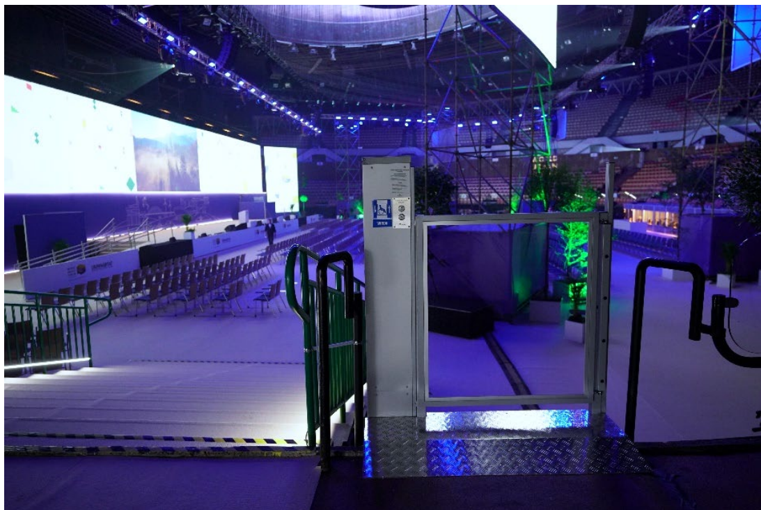
Fot. 4. Podnośnik pionowy zainstalowany tymczasowo na potrzeby WUF11 na głównej sali katowickiego Spodka, fot. M Kuświk
