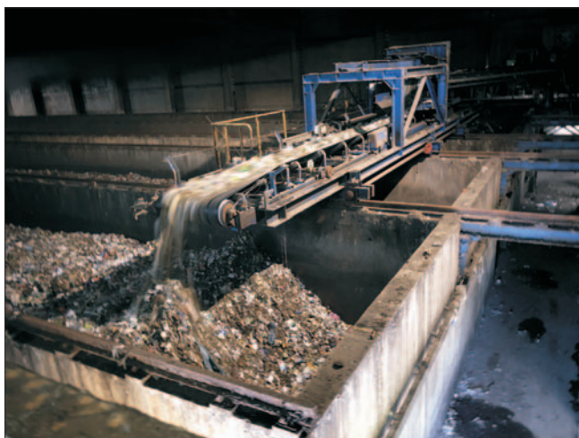
Ryc. 29. Biostabilizacja
