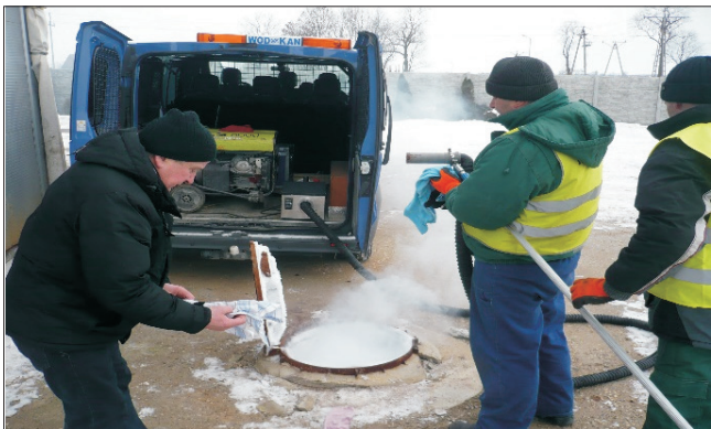
Ryc. 32. Inwentaryzacja systemów kanalizacyjnych z zastosowaniem wytownicy dymu.
