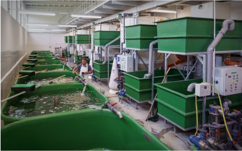
Zmodernizowana i rozbudowana wylęgarnia dzięki wsparciu z Programu Operacyjnego „Rybnictwo i Morze”. ■ Hatchery modernised and developed with the use of support from the "Fisheries and Sea" Operational Programme.
