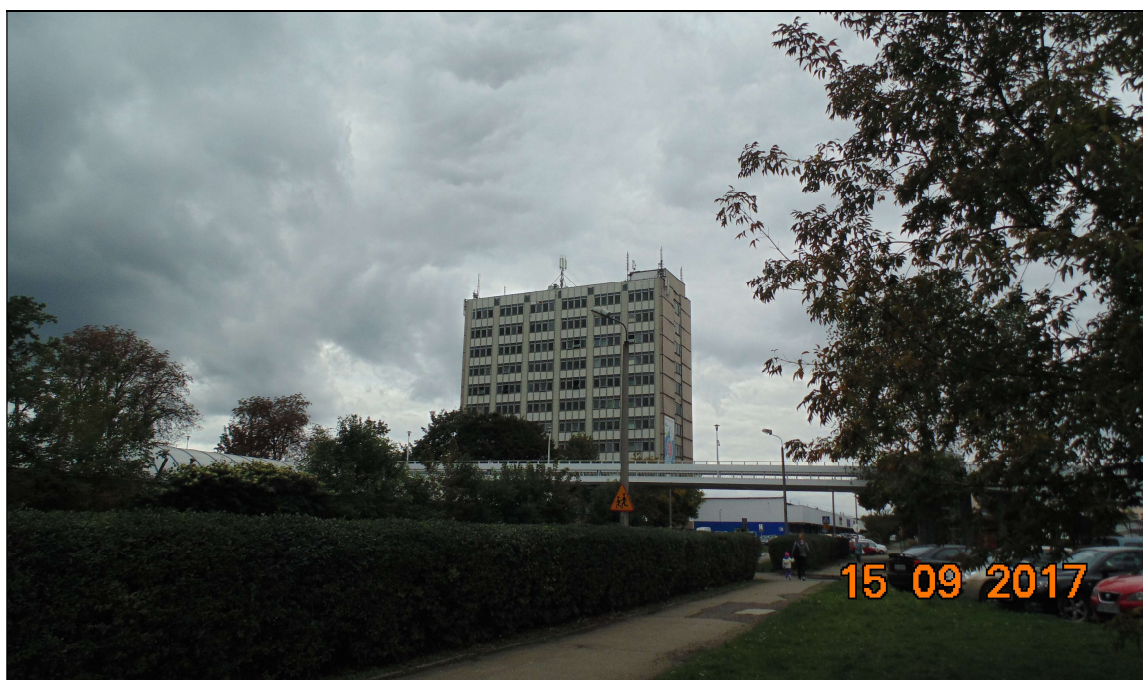
Fot.4. Rejon badań, widok w kierunku zachodnim, biurowiec przy ul. Teatralnej 9
