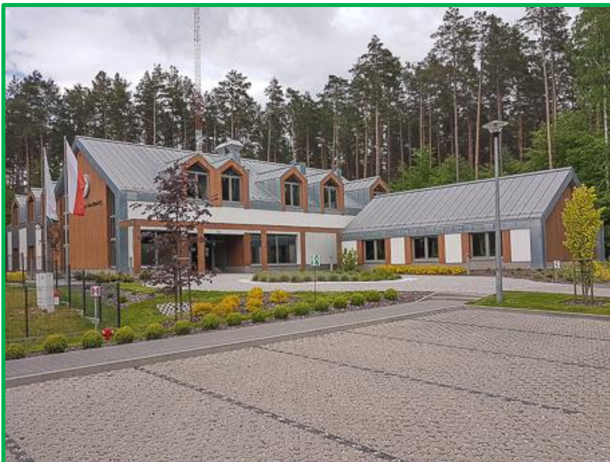
Fot.1. Siedziba Nadleśnictwa Niedźwiady (fot. Nadleśnictwo)
