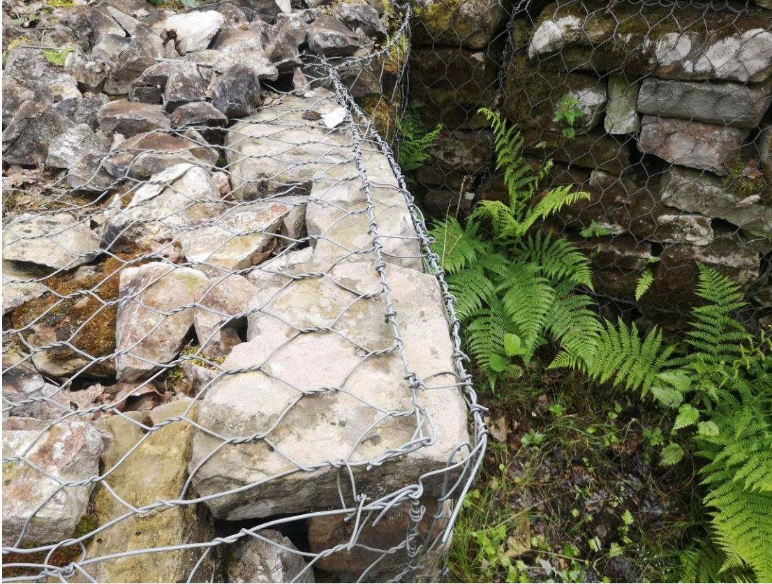
Zdj. nr: 2 - Uszkodzone połączenia siatek
