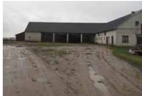
Nieutwardzona, błotnista, śliska nawierzchnia podwórze, brak odprowadzenia wód opadowych
