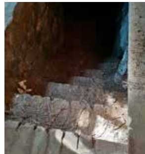
Strome, nieprawidłowo skonstruowane schody bez poręczy i barierek
