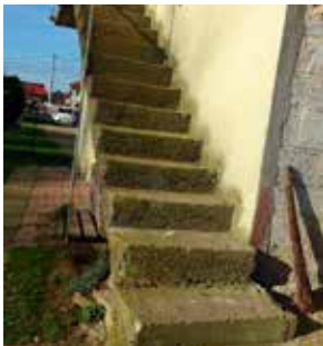
Strome, nieprawidłowo skonstruowane schody bez poręczy i barierek
