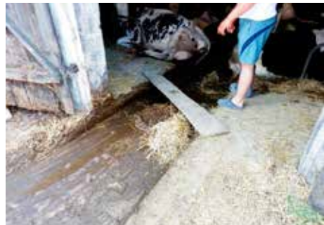
Nieprawidłowo skonstruowane stanowiska dla zwierząt, brak zabezpieczenia kanałów gnojowych
