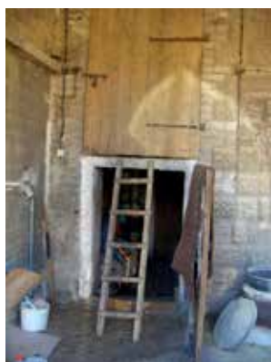
Krótkie, nieprawidłowo skonstruowane i ustawione drabiny, bez zabezpieczeń przed przechyłem i osunięciem
