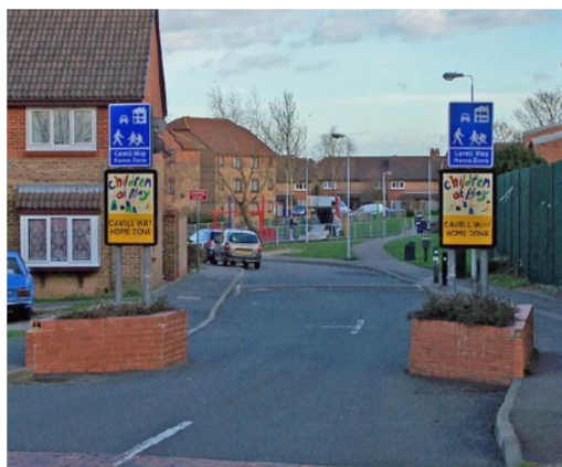
Rys. 3.7. Przykłady zastosowania dodatkowych środków budowlanych przy wjazdach do stref zamieszkania. Źródło: [3].
