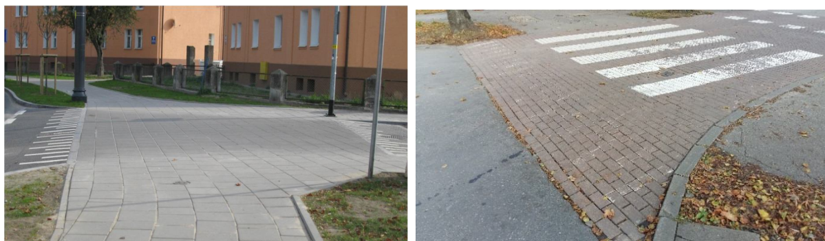
Rys. 4.15. Przykład wyniesienia chodnika na zjeździe. Źródło: fot. własne.
