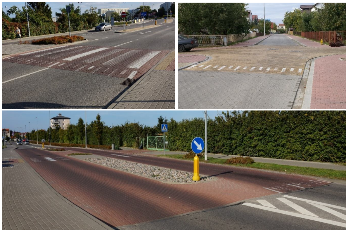
Rys. 4.12. Wyniesione skrzyżowanie i przejście dla pieszych. Źródło: fot. własne.
