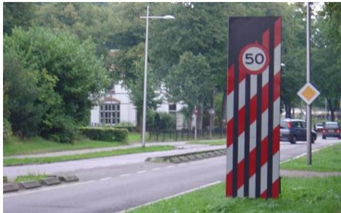
Rys. 4.3. Przykład bramy wjazdowej do miejscowości.
