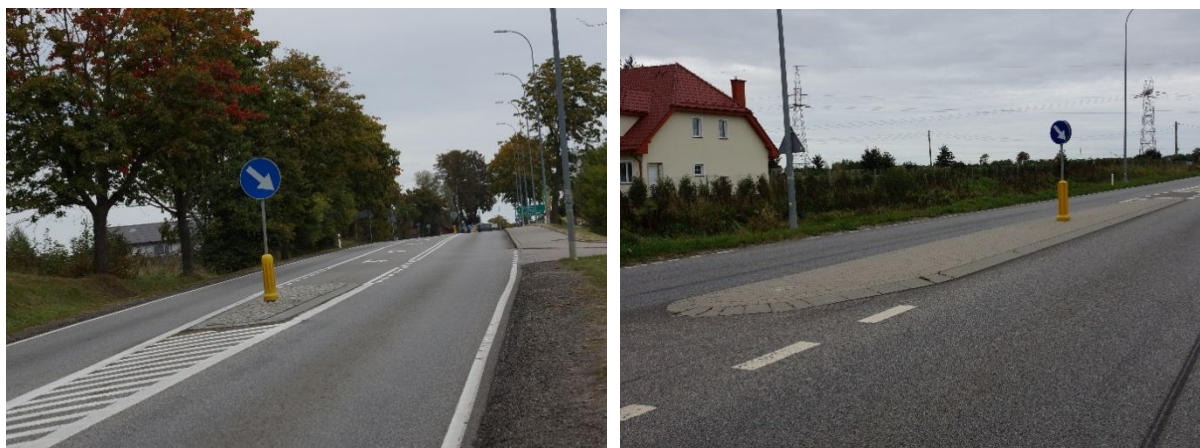
Rys. 4.4. Przykłady wysp na wjeździe do miejscowości.
