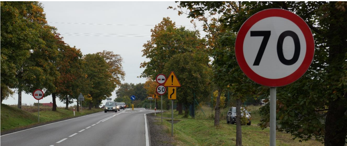
Rys. 4.7. Modelowe rozwiązanie zastosowania wyspy wjazdowej do miejscowości.
