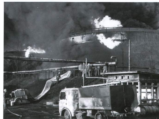
Ploną zbiorniki nr 253 i 252. Strażacy rozwijają linię gaśniczą do podawania piany lekkiej
