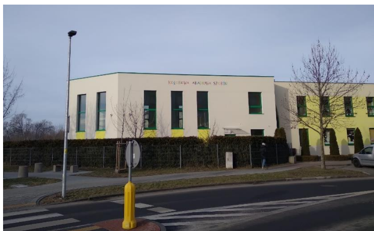
Rysunek 4. Obiekt sali gimnastycznej przy Przedszkolu Niepublicznym „Tęczowa Chatka” Justyna Jastrzębska we Wrześni. Obiekt został oddany do użytku w 2023 r.
