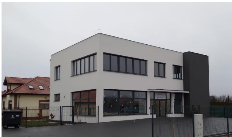
Rysunek 3. Obiekt Przedszkola Niepublicznego „Akademia Serdeczna” Zuzanna Zdunek we Wrześni. Obiekt został oddany do użytku w 2023 r. – przedszkole zlokalizowane jest w poziomie parteru.
