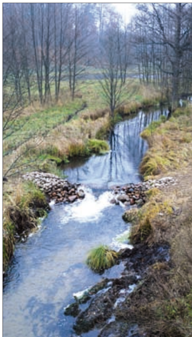
Fot. 21, 22. Progi i ostrogi kamienne wykonane w ramach projektu
