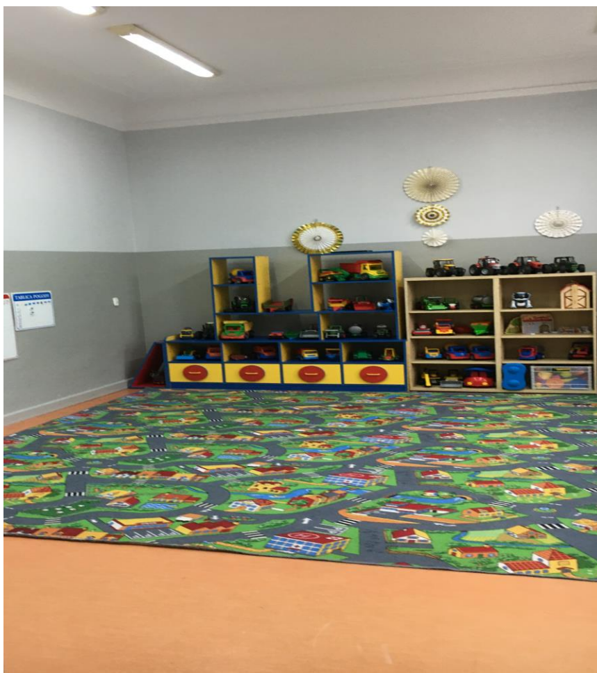
Zdjęcie nr 13. Odmalowane ściany w sali zajęć w Zespole Szkoły Podstawowej i Przedszkola w Belęcinie
