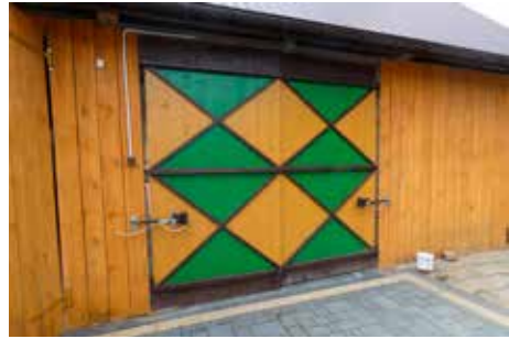
OR KRUS w Białymstoku – fotografia zgłoszona do konkursu fotograficznego dla rolników, przedstawiająca zabezpieczenie drzwi przed samoczynnym zamknięciem
