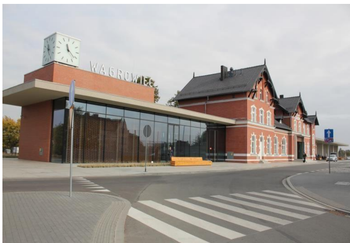
Dworzec kolejowy w Wągrowcu po modernizacji.
