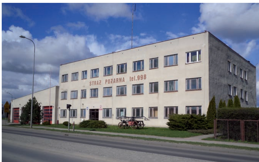
Budynek strażnicy przed termomodernizacją, kwiecień 2014 r.
