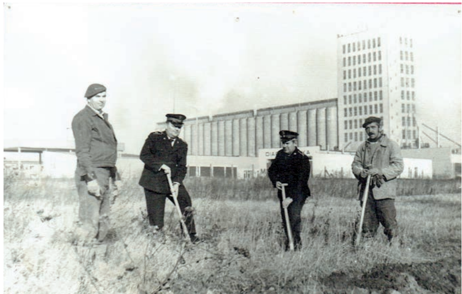
Komendant Rejonowy st. chor. poż. Jerzy Dowiat i st. ogn. poż. Henryk Armista dokonują symbolicznego rozpoczęcia budowy – pierwsze łopaty wbijane w ziemię pod fundamenty
