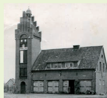
Budynek Komendy Straży Pożarnych w Bartoszczych, lata 70. XX w.
