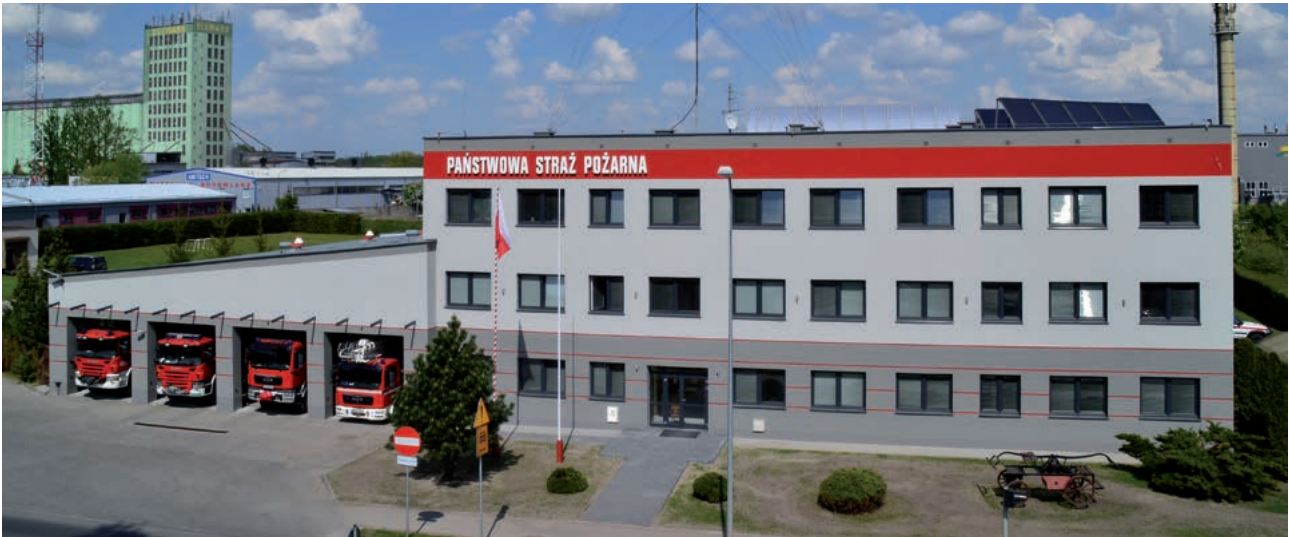
Budynek KP PSP Bartoszyce po termomodernizacji 2016 r.
