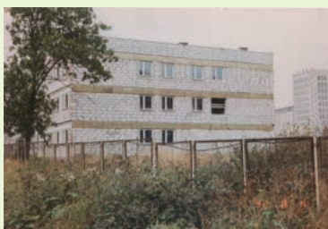
Budynek strażnicy ul. Bema 36, stan surowy zamknięty, sierpień 1992 r.
