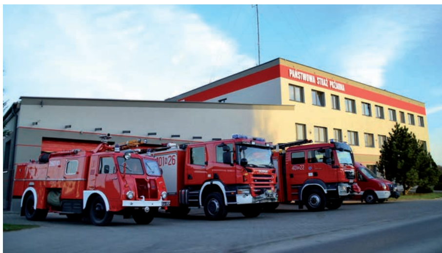
Komenda Powiatowa PSP w Bartoszcach po modernizacji
