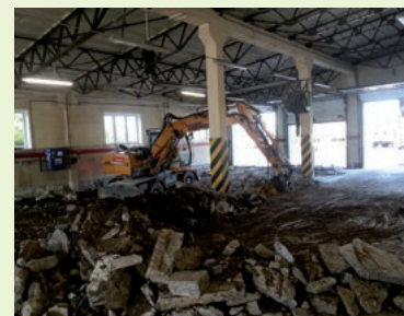
Usuwanie starej posadzki garażu głównego, 27.10.2015 r.
