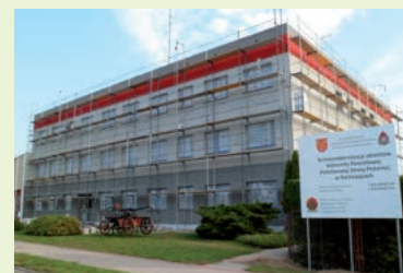
Budynek w trakcie termomodernizacji
