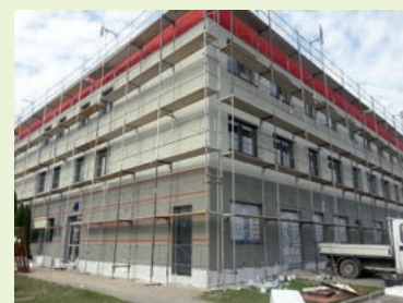
Wykonanie elewacji skrzydła południowo-wschodniego
