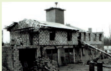
Budowa strażnicy OSP Górowo Ił. zdjęcie wykonano do kroniki, 11.01.1989 r.
