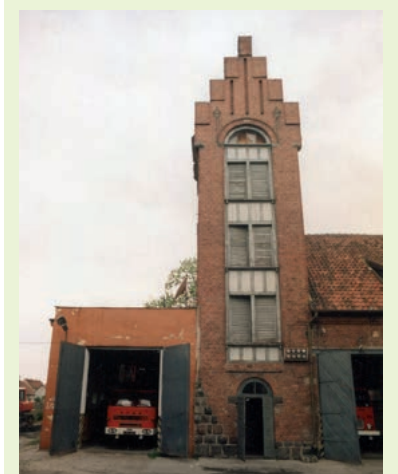
Remiza Straży Pożarnych
