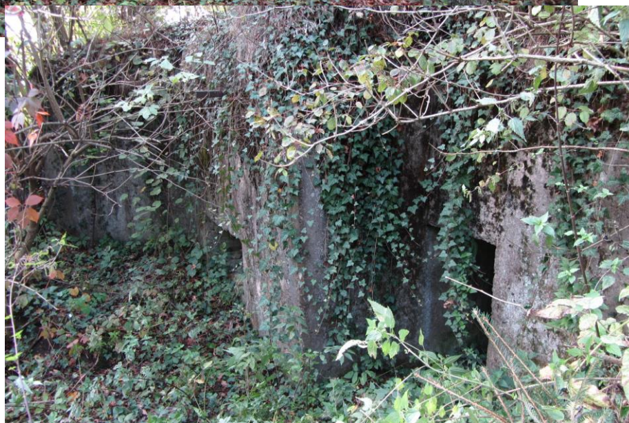
Fot. Bunkry z „Linii Mołotowa” w leśnictwie Jabłonica
