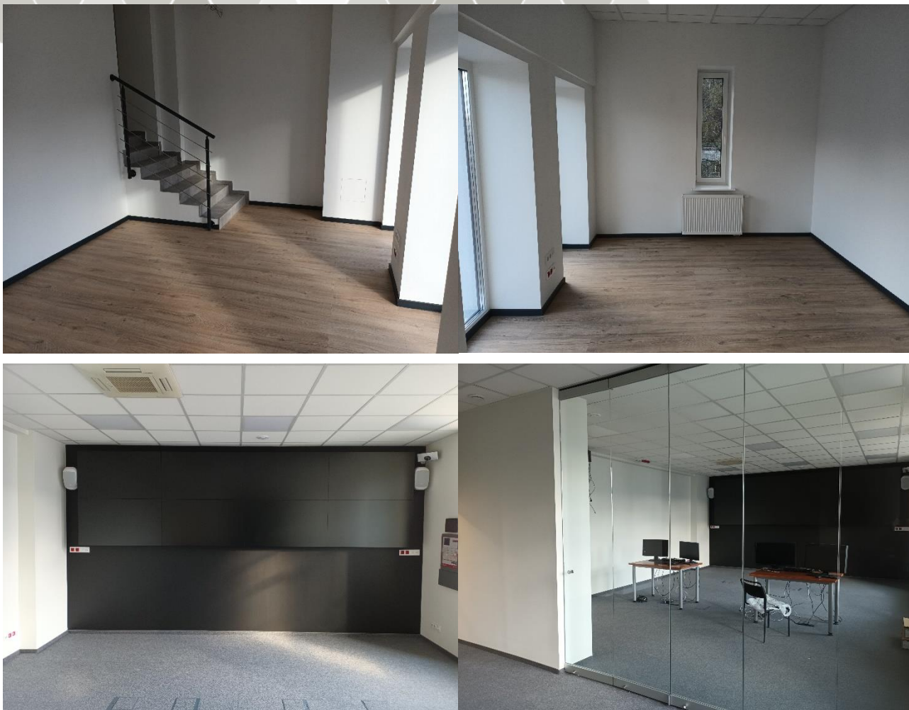
Fot. 4 Przebudowa pomieszczeń w KW PSP w Gdańsku.
