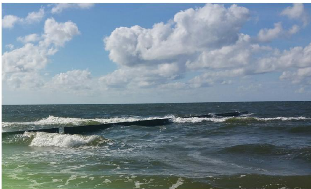
Fot. 11. Przerwana ostroga na wysokości jeziora Kopań (sierpień 2016 r.)
