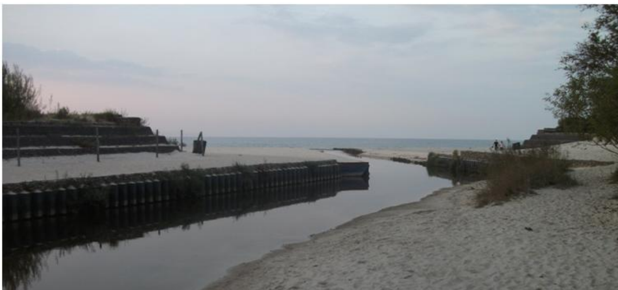
Fot. 19. Ostrowo. Obudowa wylotu rzeki Czarna Woda (wrzesień 2016 r.)
