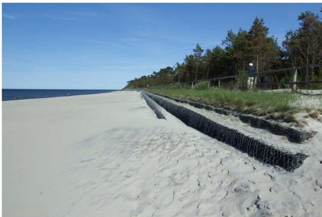
Fot. 25. Gabiony w rejonie Jastrzębia Góra – Ostrowo: początek naturalnego rozwoju wegetacji na koronie sztucznie utworzonej wydmy
