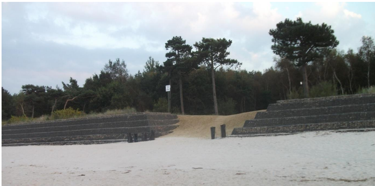
Fot. 18. Ostrowo. Konstrukcja ochronna wydmy i zejście na plażę (wrzesień 2016 r.)
