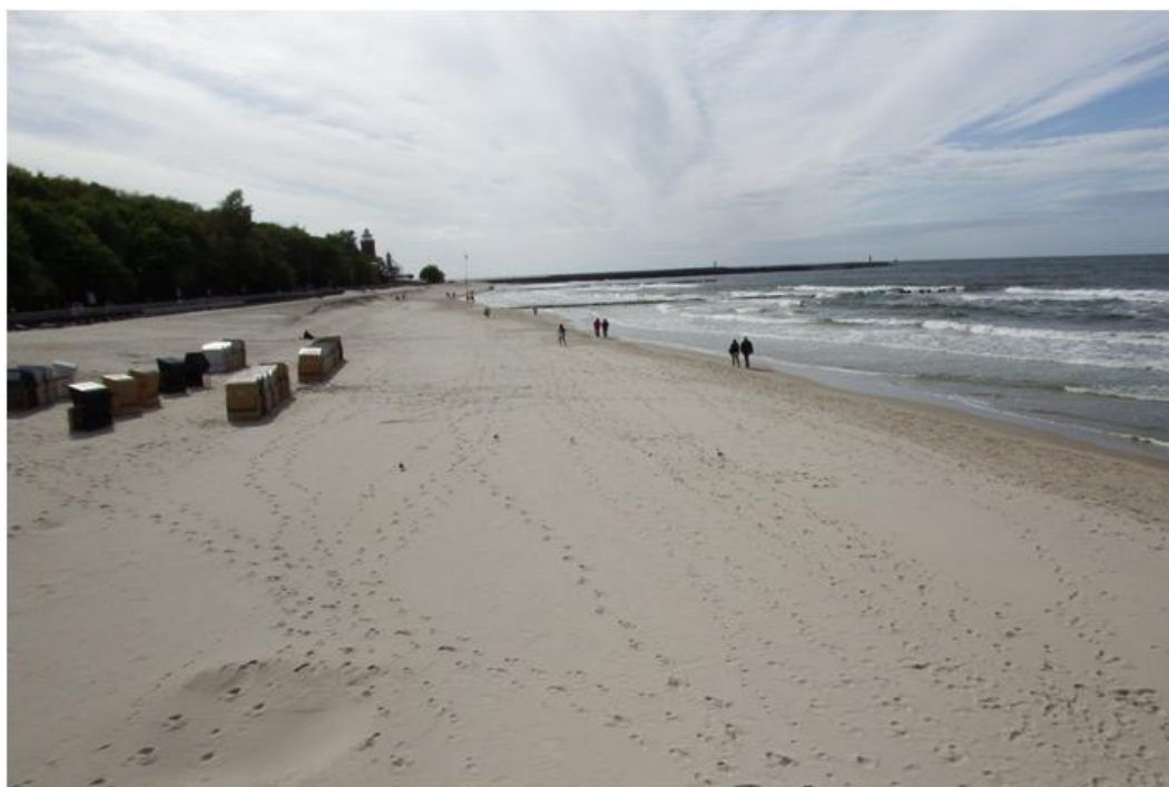
Fot. 33. Plaża w Kołobrzegu po wykonaniu systemu ochronnego
