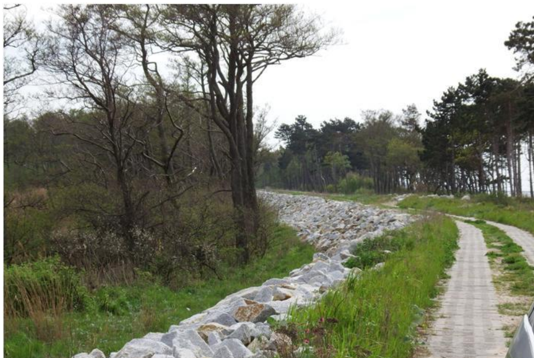
Fot. 27. Wał przeciwsztormowy na mierzei jeziora Kopań
