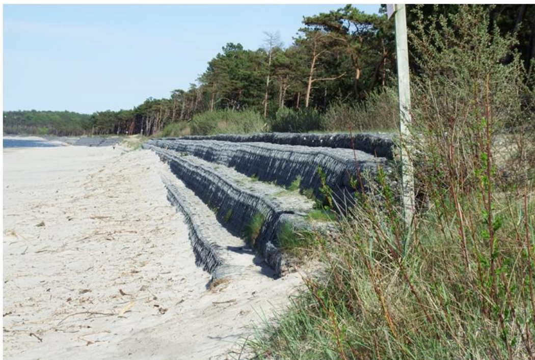
Fot. 42. Gabiony jako konstrukcje wzmacniające wydmy o minimalnym wpływie na środowisko
