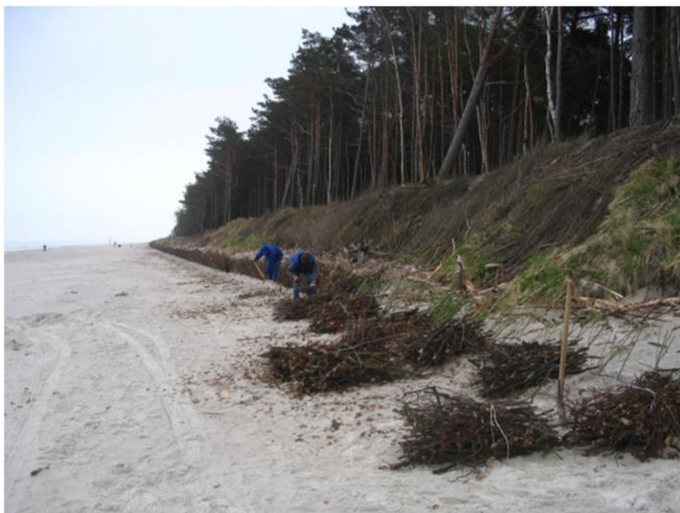
Fot. 41. Wiązki chrustu chroniące czoło wydmy po okresie zimowym, Lubiawo, rejon odpowiedzialności UM Gdynia
