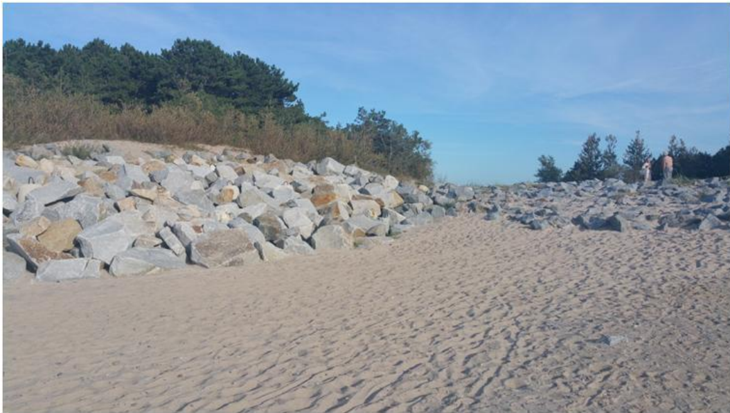
Fot. 7. Opaska brzegowa narzutowa przy przetoce jeziora Jamno (wrzesień 2016 r.)
