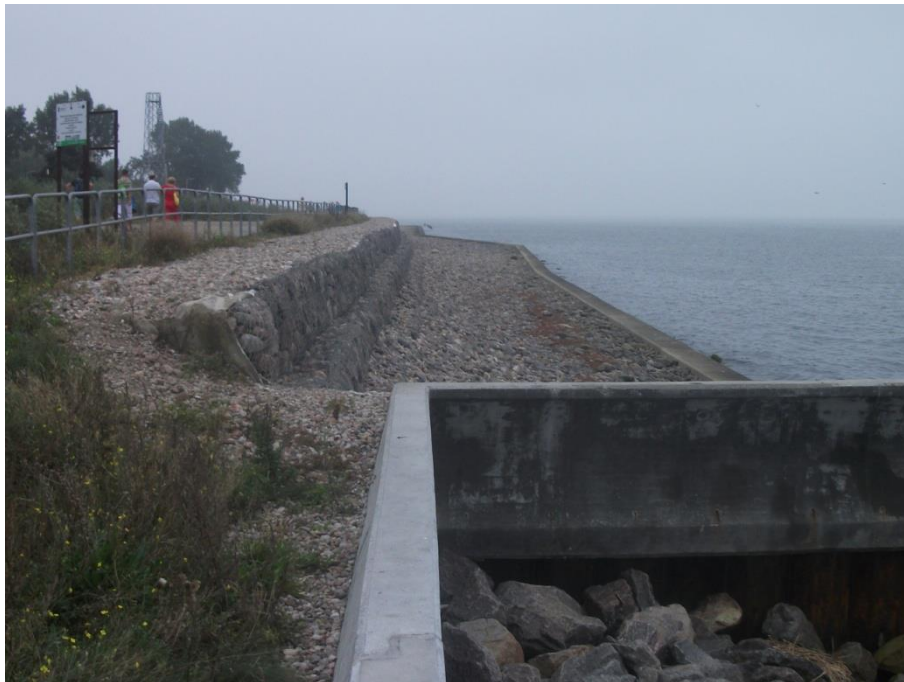
Fot. 23. Cypel Helski. Przebudowane umocnienia brzegu (wrzesień 2016 r.)
