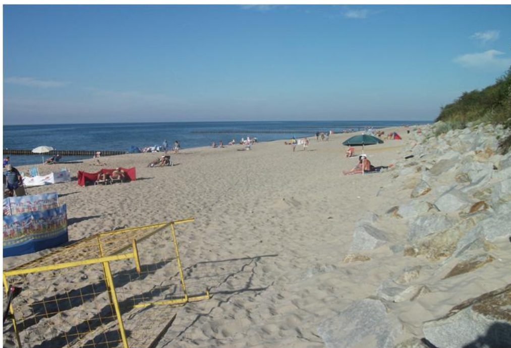
Fot. 3. Rewal, plaża. Po lewej stronie ostrogi, po prawej – opaska u podstawy klifu (wrzesień 2016 r.)
