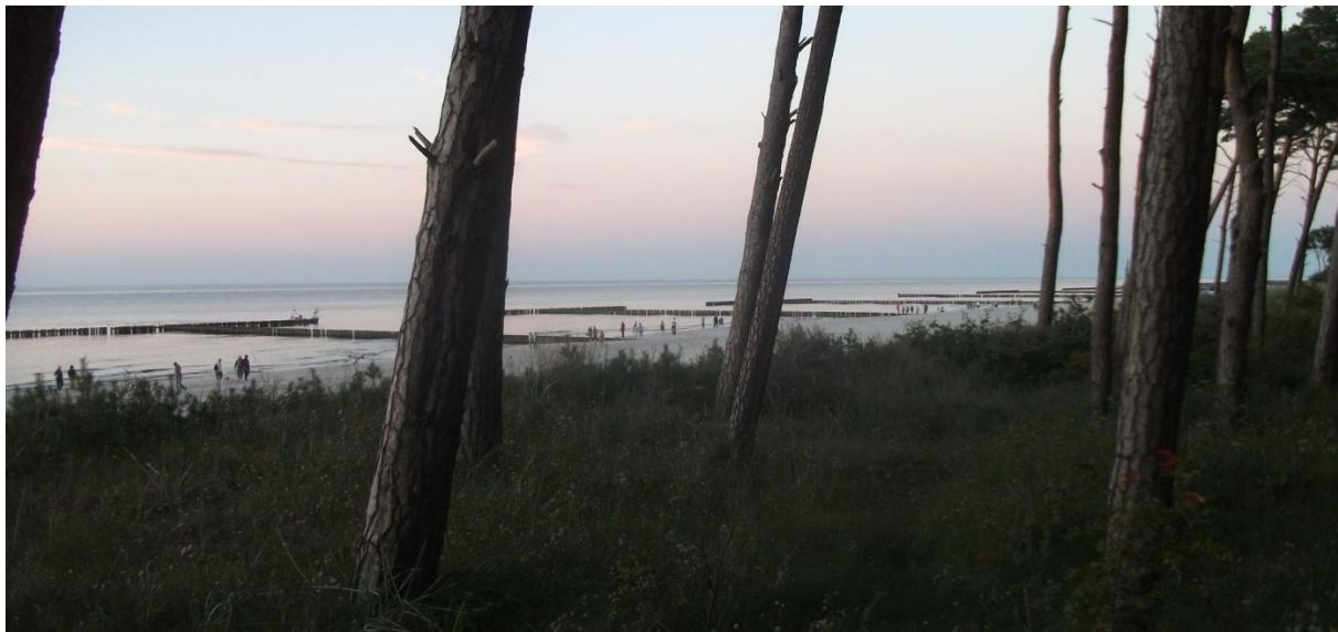
Fot. 8. Ostrogi typu „T” w Dźwirzynie (wrzesień 2016 r.)
