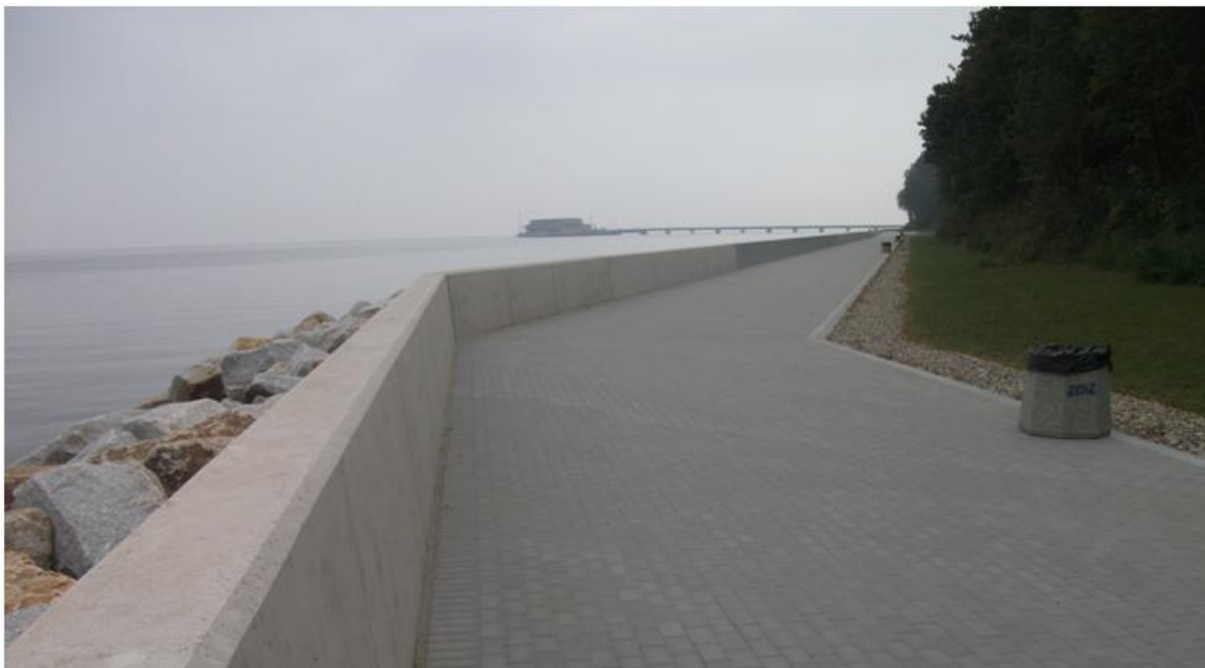
Fot. 21. Oksywie. Bulwar z narzutem kamiennym i zasypem na geokracie (wrzesień 2016 r.)
