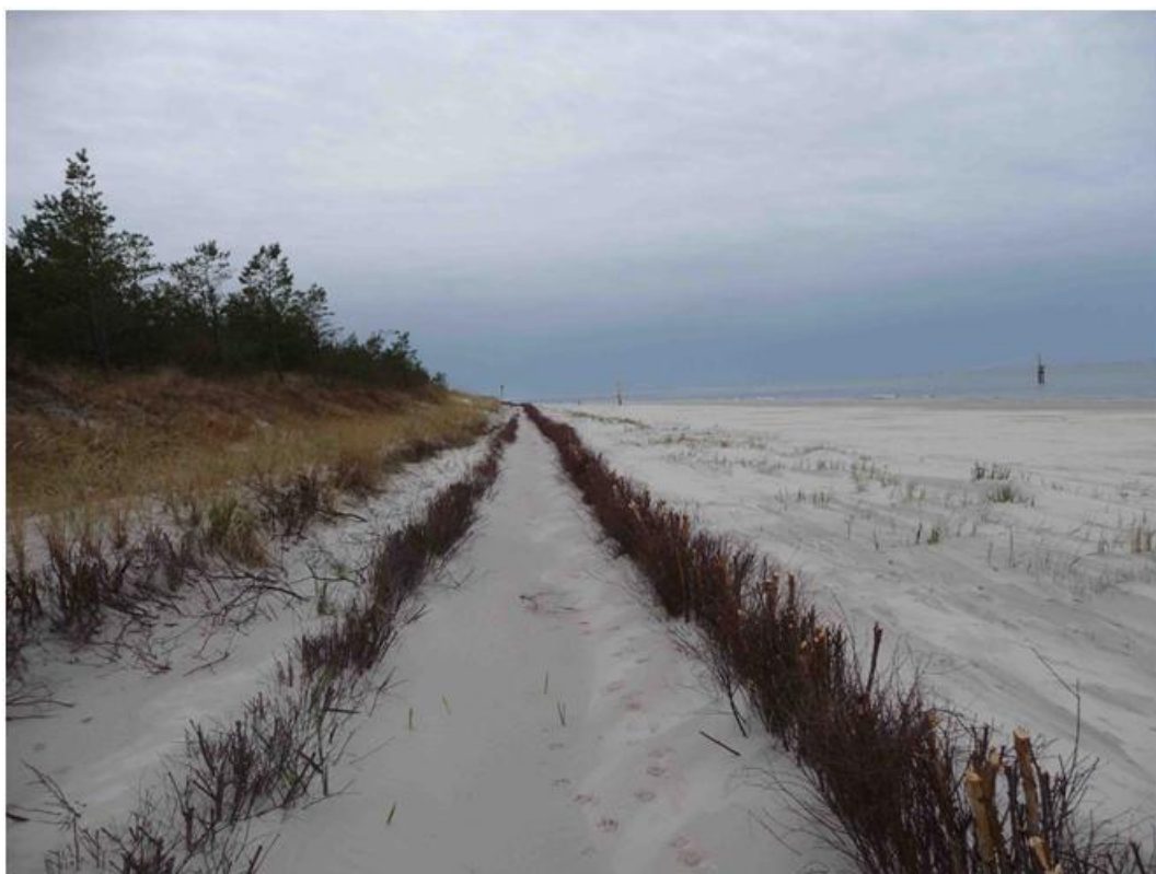
Fot. 40. Płotki wydmotwórcze, Lubiawo, rejon odpowiedzialności UM Gdynia
