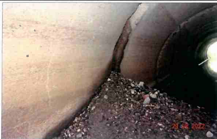
Fot. 5 Element rurowy korozja zbrojeni, ubytki betonu, obsypanie gruntu z przemieszczonych kręgów przepustu
