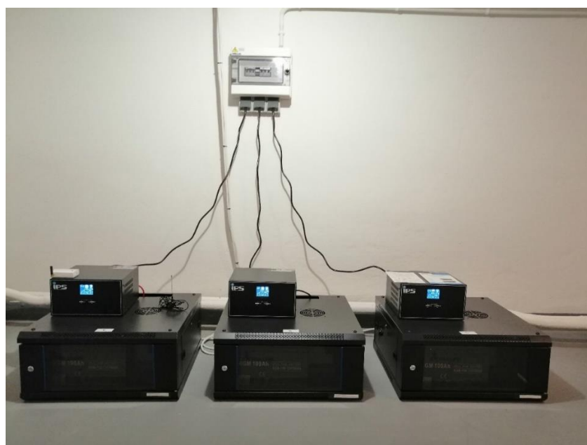
Zdj. Układ podtrzymania energii zapewniający zasilanie awaryjne lodówek, w których przechowywane są preparaty szczepionkowe magazynie PSSE w Rzeszowie
