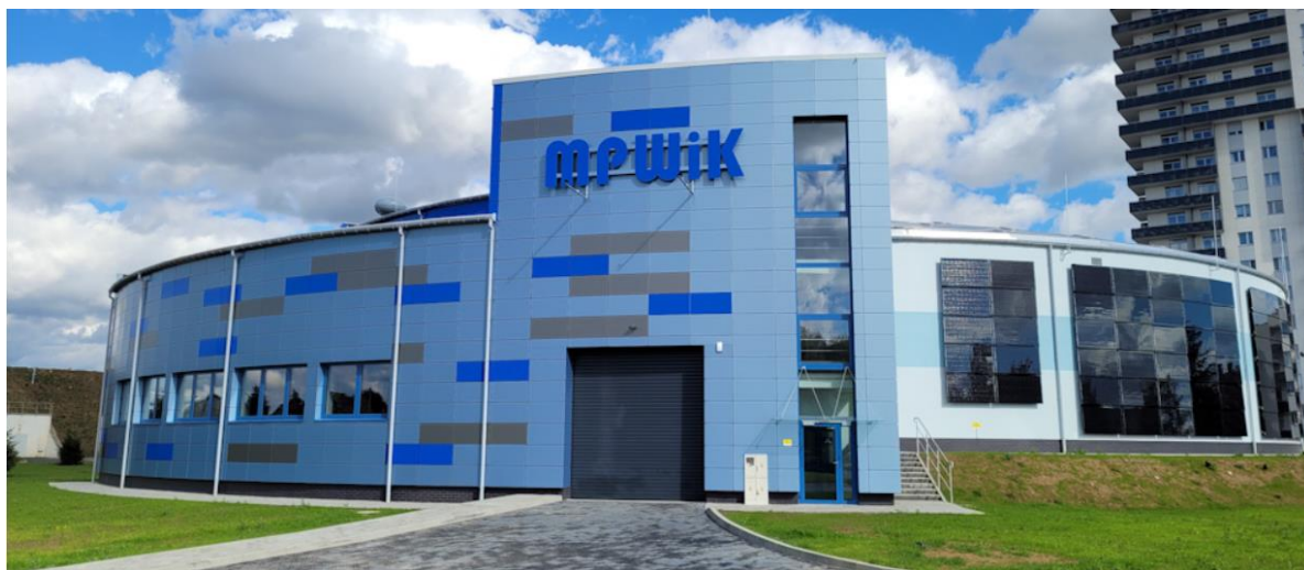
Fot. Nowe zbiorniki wody pitnej Rzeszów-Pobitno (źródło: https://mpwik.rzeszow.pl )
