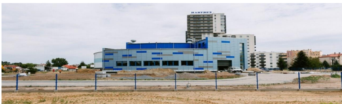
Fot. Zbiornik wody pitnej przy ul. Kurpiowskiej i Morgowej w Rzeszowie (źródło: https://www.resinet.pl/aktualnosci/rzeszow/w-rzeszowie-otwarto-nowy-zbiornik-na-wode-pitna.html )
