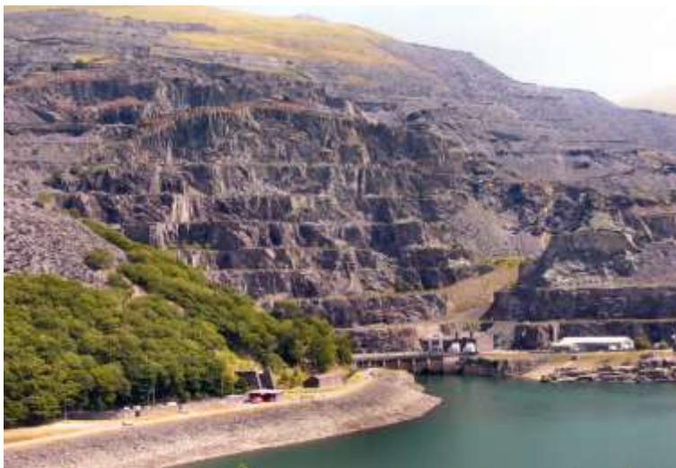
Rys. 10. Elektrownia szczytowo-pompowa Dinorwig w Walii.
