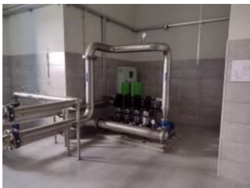
Zestaw hydroforowy- hydrofornia w Potulinie Fot. Alina Borlikowska
