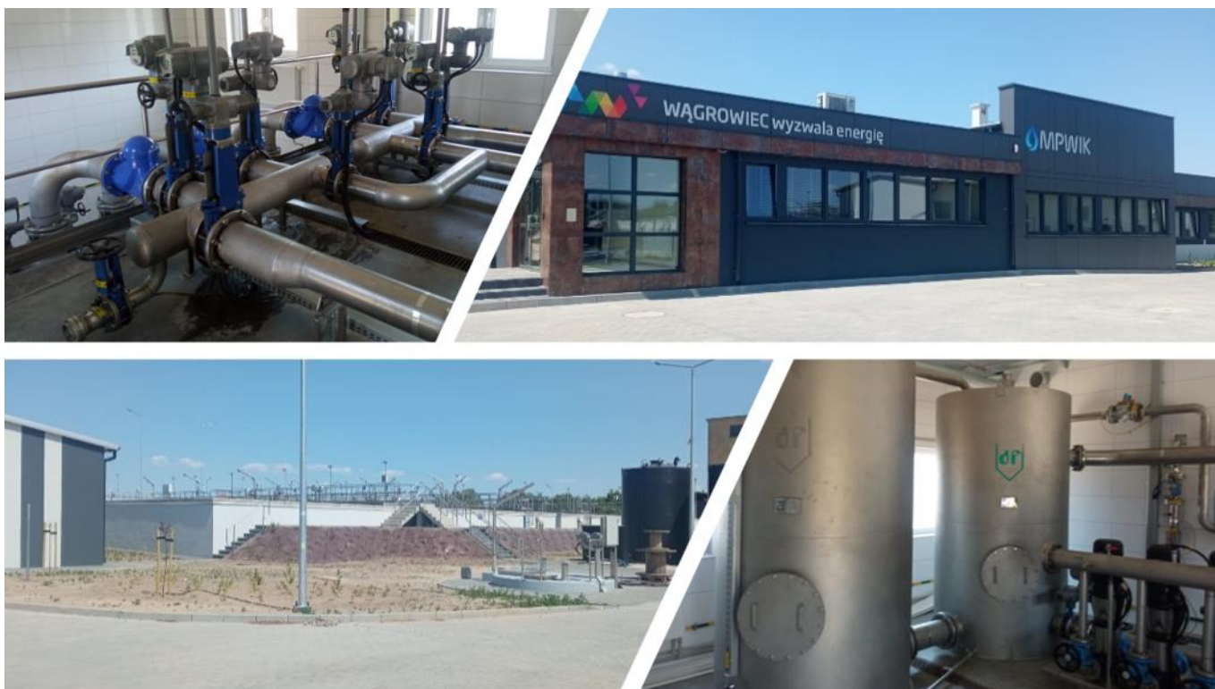
Budynek oczyszczalni ścieków w Wągrowcu – odebrany w czerwcu 2023 r.
