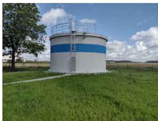
Zbiornik wody uzdatnionej wodociągu publicznego w Potulinie Fot. Alina Borlikowska
