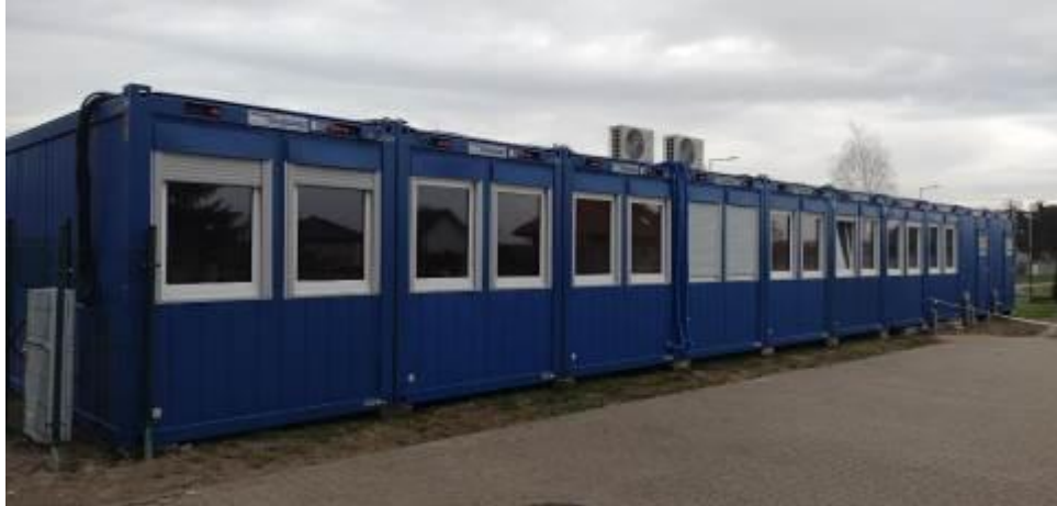
Budynek kontenerowy przy Szkole Podstawowej w Mieścisku Fot. Iwona Senger
