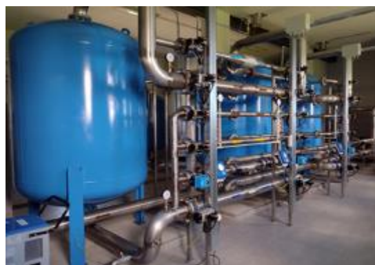
Odżelaziacze i odmanganiacze- hydrofornia w Potulinie Fot. Alina Borlikowska
