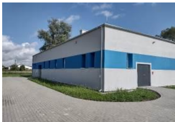
Budynek hydrofornia w Potulinie Fot. Alina Borlikowska
