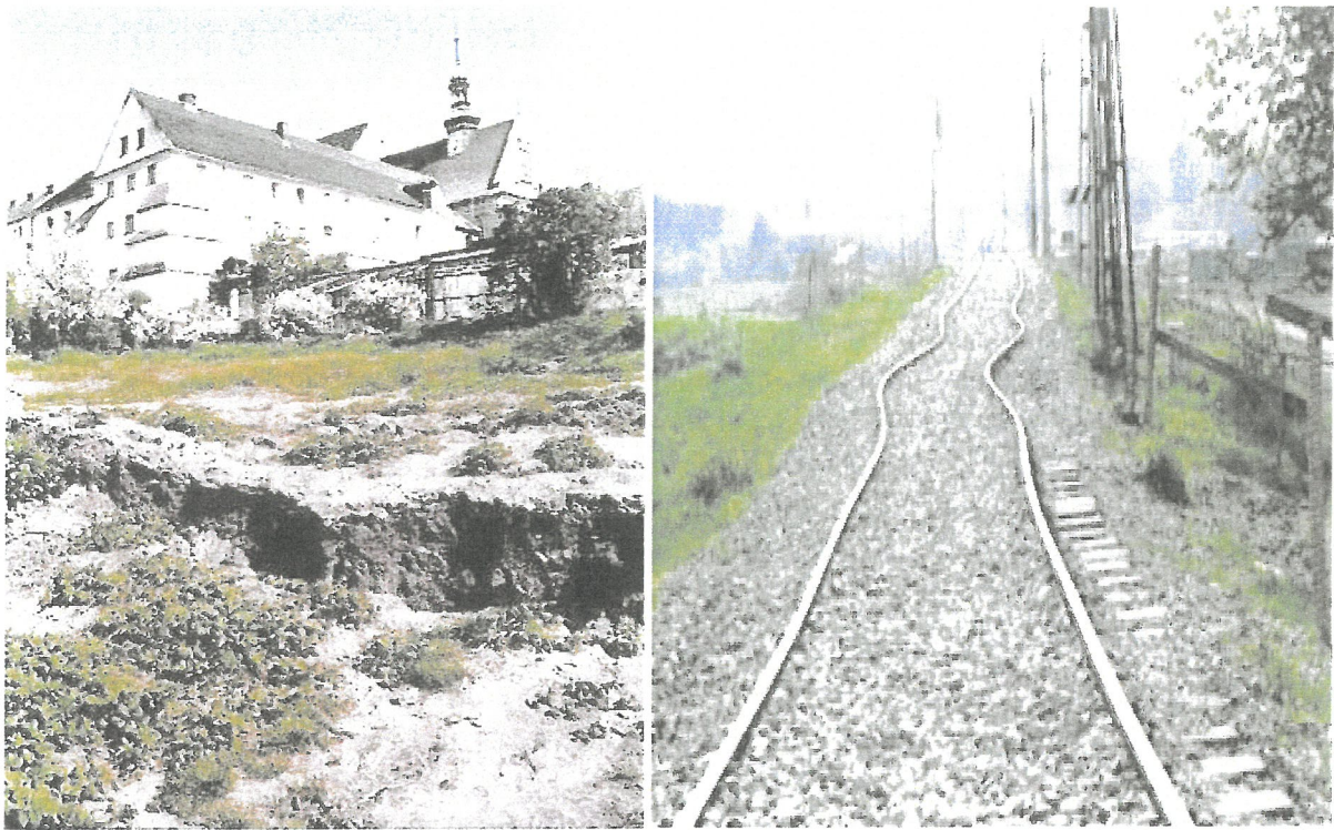
Rys. 6 i 7 Szkody na powierzchni w niecce osiadań w rejonie Klasztoru o.o. Franciszkanów-Reformatów i linii kolejowej
