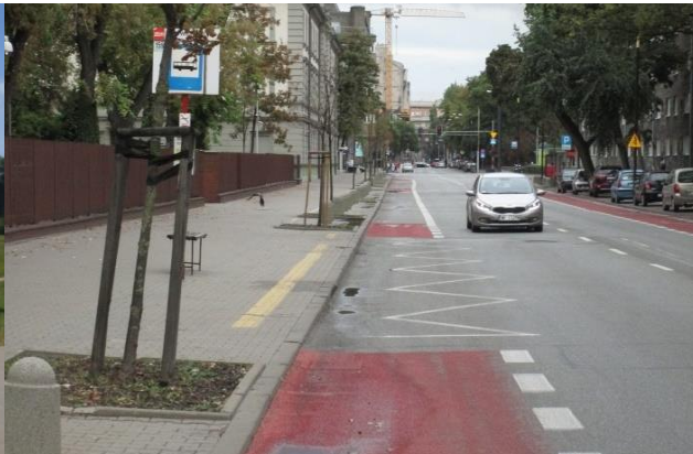
Fot. 6.24. Infrastruktura w rejonie przystanków komunikacji publicznej – pas ruchu dla rowerów z przerwą na przystanek autobusowy
