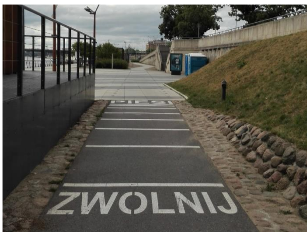
Fot. 6.25. Urządzenia uspakajające ruch rowerów
