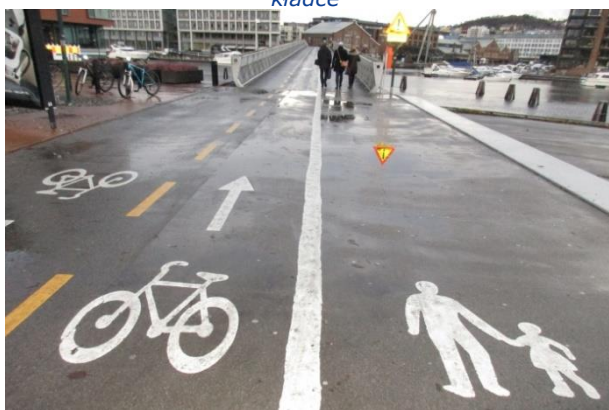
Fot. 6.40. Kładka pieszo-rowerowa
