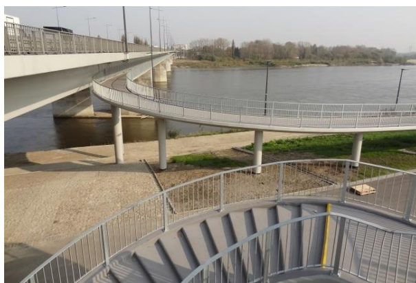
Fot. 6.39 Droga dla rowerów na moście
