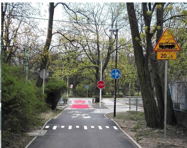
Fot. 6.30. Próg zwalniający na drodze dla rowerów
