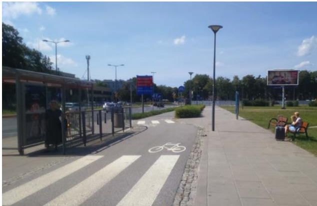
Fot. 6.23. Infrastruktura w rejonie przystanków komunikacji publicznej – droga dla rowerów omija zatokę autobusową z tyłu
