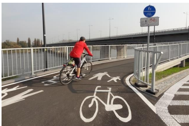
Fot. 6.38 Wspólna droga dla rowerów i pieszych na kładce
