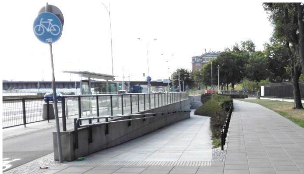
Fot. 6.42 Przepust dla pieszych i rowerzystów
