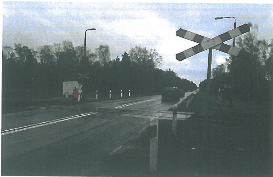
Zdjęcie przejazdu kat. A w km 37,119 szlaku Śniadowo – Łapy linii kolejowej nr 36 – widok od strony nadjeżdżającego samochodu przed znakiem G-3 (Krzyż św. Andrzeja).
