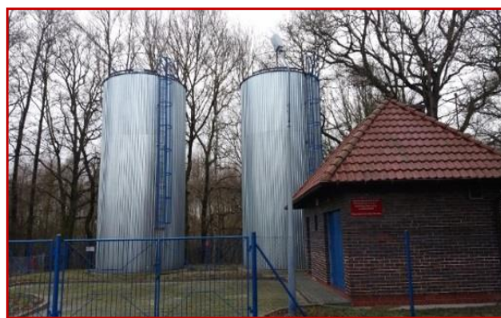
Fot. Wodociąg publiczny Szprotawa gm. Szprotawa – zbiorniki do gromadzenia wody uzdatnionej w Szprotawie i w Lesznie Dolnym.
