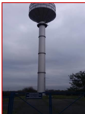
Fot. Wodociąg publiczny Szprotawa gm. Szprotawa – zbiorniki do gromadzenia wody uzdatnionej w Szprotawie i w Lesznie Dolnym.
