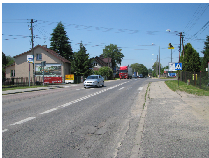
Fot. 3. Jaworzno, RB1. Badany odcinek ul. Katowickiej w kierunku Sosnowca
