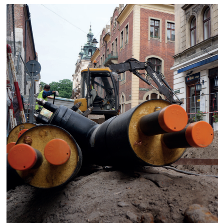
Układanie sieci ciepłowniczej na Starym Mieście w Krakowie przez MPEC
