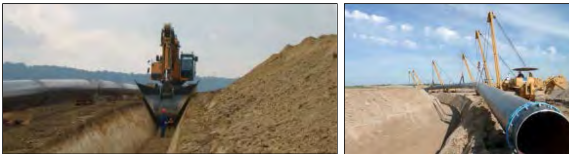
Rys. 6-21 Wykonywanie wykopu pod rurociąg lądowy (po lewej) i opuszczanie rurociągu do wykopu.
