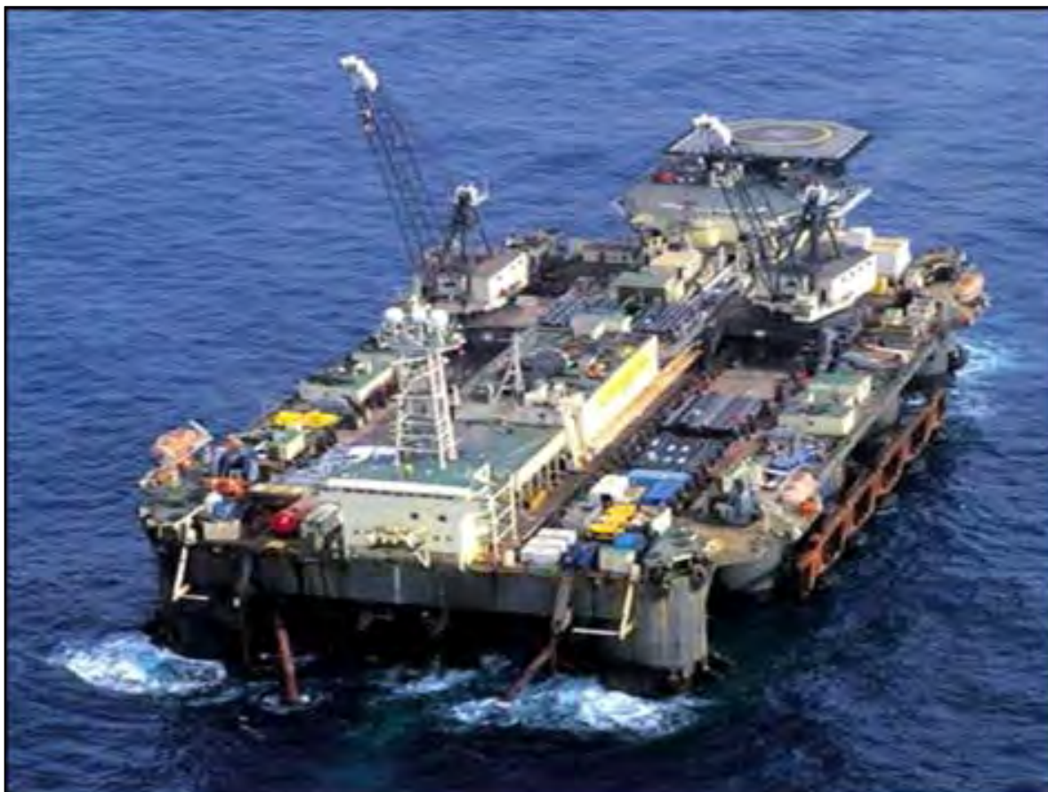
Rys. 6-13 Statek do układania rurociągu Castoro Sei .
