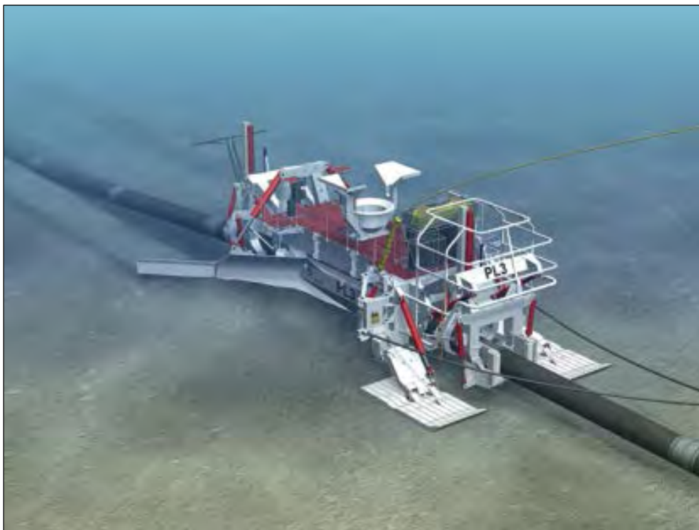
Rys. 6-15 Pług rurociągowy pracujący na dnie morskim.
