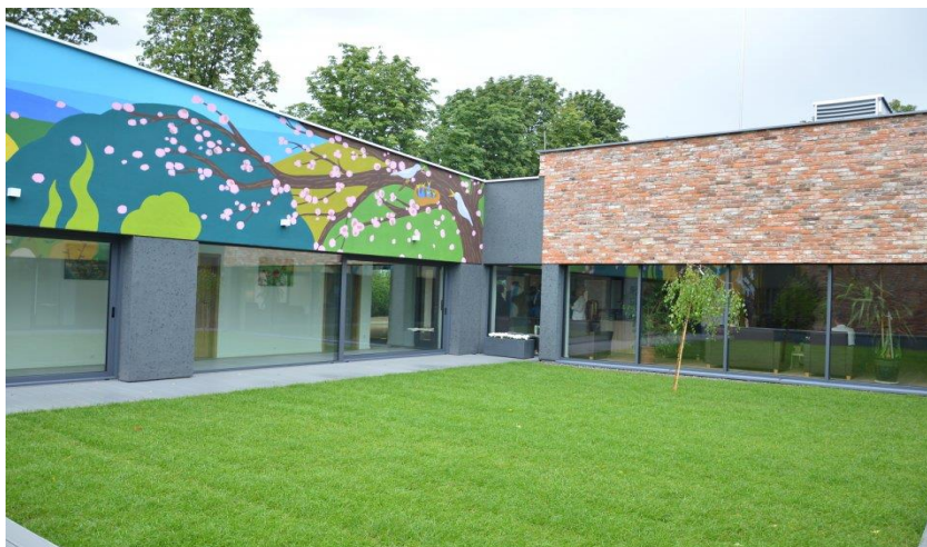
Zdjęcie 8. Nowy budynek Schroniska dla bezdomnych w Jankowicach gm. Ożarów
