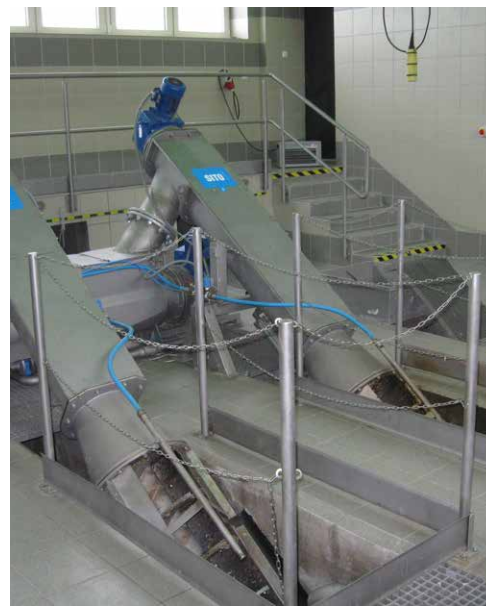
Óś Kłobuck mechaniczne oczyszczanie ścieków - sita spiralne
