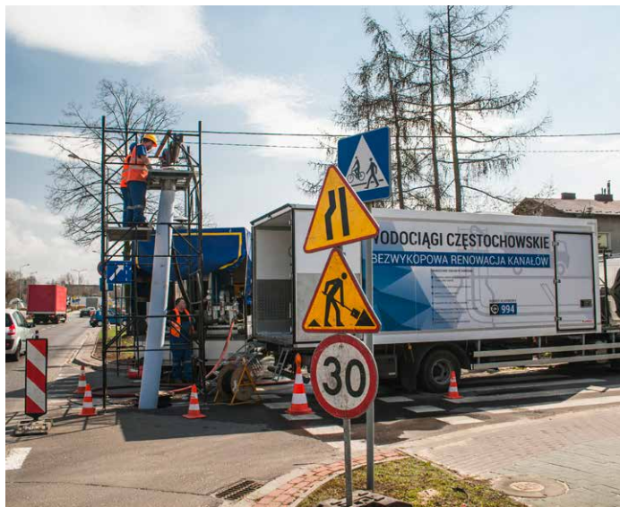
Realizacja bezwykopowej renowacji sieci kanalizacyjnej
