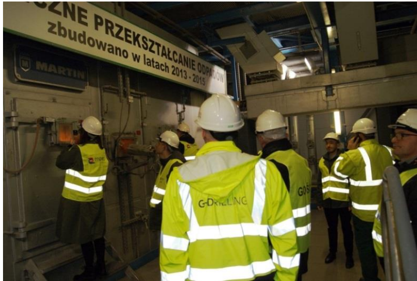
W Zakładzie Termicznego Unieszkodliwiania Odpadów. MZGOK Sp. z o.o. (fot. MPEC-Konin)
