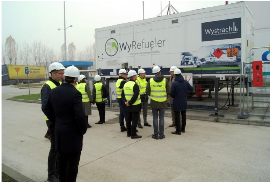
Stacja tankowania wodoru do autobusu miejskiego z ogniwami paliwowymi. Teren Elektrowni Konin (fot. MPEC-Konin)
