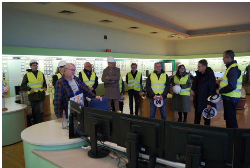
W dyspozytorni Elektrowni Konin (fot. MPEC-Konin)
