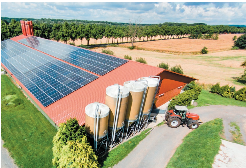
W naborze wniosków dotyczącym wsparcia na zakup i montaż silosów wraz z wyposażeniem wpłynęło blisko 13 tys. wniosków na kwotę ponad 510 mln zł
