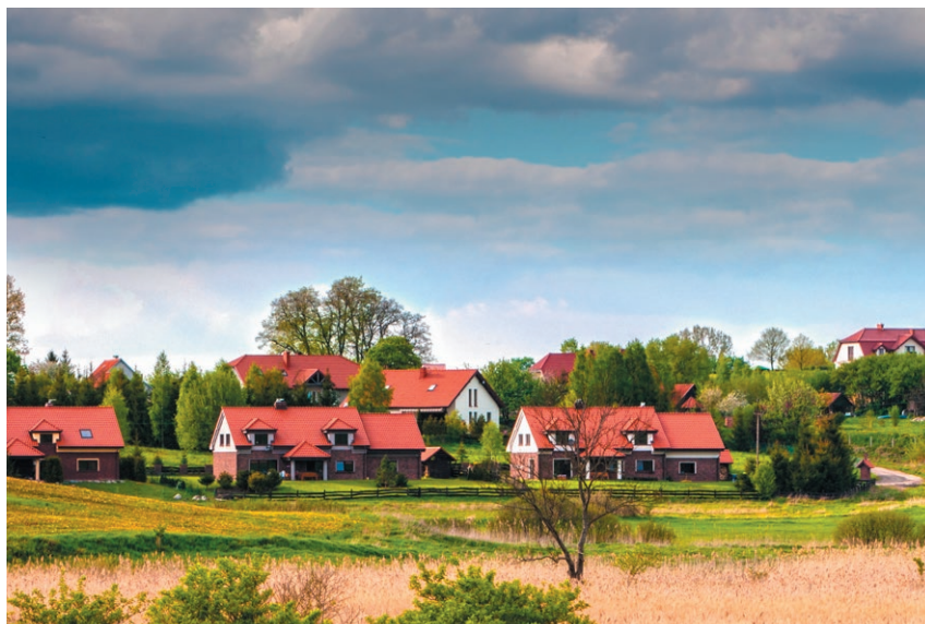
W naborze dotyczącym wsparcia na wymianę pokryć dachowych z materiałów szkodliwych dla zdrowia lub środowiska wpłynęło ponad 47 tys. wniosków
