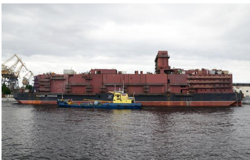
Rys. 3. Pływająca EJ Akademik Lomonosov budowana w stoczni Baltijskiy Zavod
