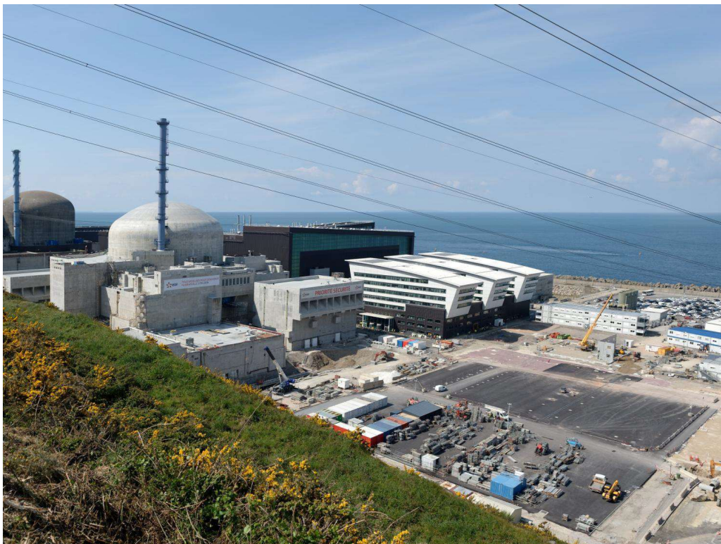
Rys.2. Widok na plac budowy Flammanville 3 (kwiecień 2017); źródło EDF
