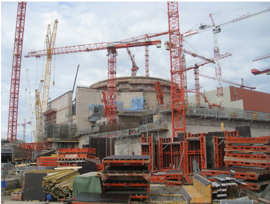
Rys.7. Zdjęcia z budowy elektrowni Olkulioto 3 w Finlandii (lipiec 2009); źródło: BBC World Service via Flickr
