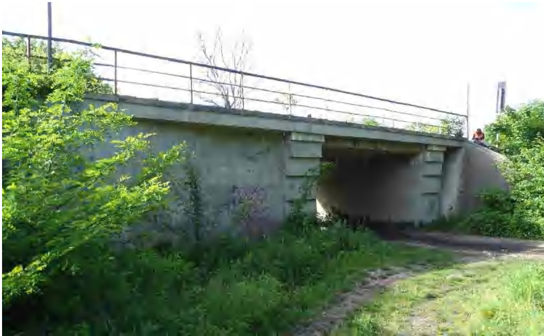
Fot. 2 Widok na wiadukt nad ul. Gorzyńską w km 342,175 linii kolejowej nr 203
