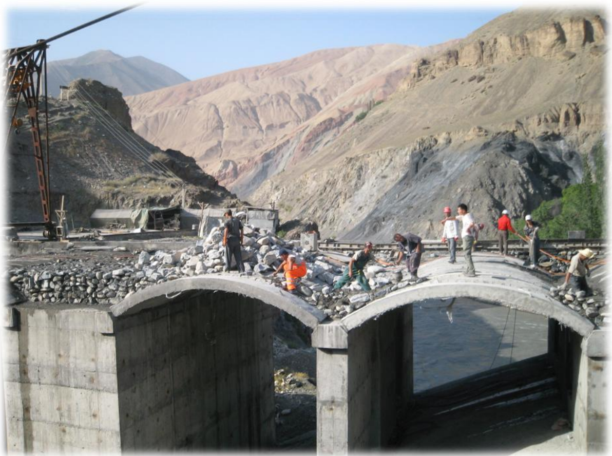
CHIŃCYCI BUDUJĄCY DROGĘ CHOROG-DUSZANBE, TADŻYKISTAN, FOT. KAMIL JARNICKI
