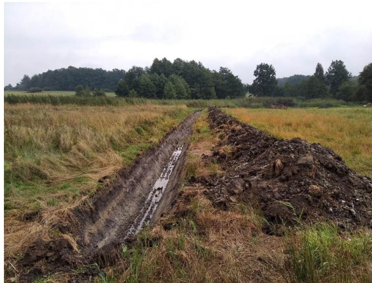
Ryc. Świeżo (we wrześniu 2020 r.) wykopany rów odwadniający turzycowisko – stanowisko V. angustior Myślinów 1 (fot. R. Ruta)
