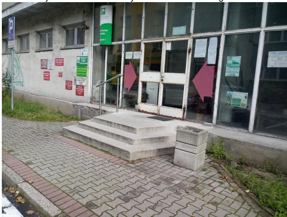
Wejście frontowe do budynku Biura Powiatowego ARiMR
