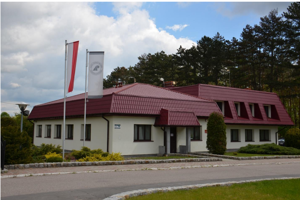
Foto 1. Siedziba Nadleśnictwa Dobrzejewice (fot. K. Czajka)
