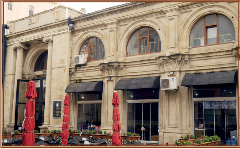
Hazırda Bakı universal mağazası kimi tanınan və indiki Rəsulzadə küçəsi, 4 ünvanında yerləşən (keçmiş Olqinski küçəsi) Tağıyev passajı. 1896-cı ildə Kazimir Skureviçin layihəsi əsasında inşa edilib.
