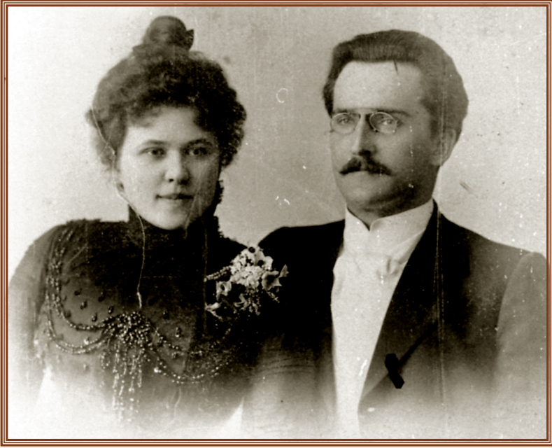
Memar Y.Ploşko həyat yoldaşı Səbinə İvanova ilə (1902-ci il).
