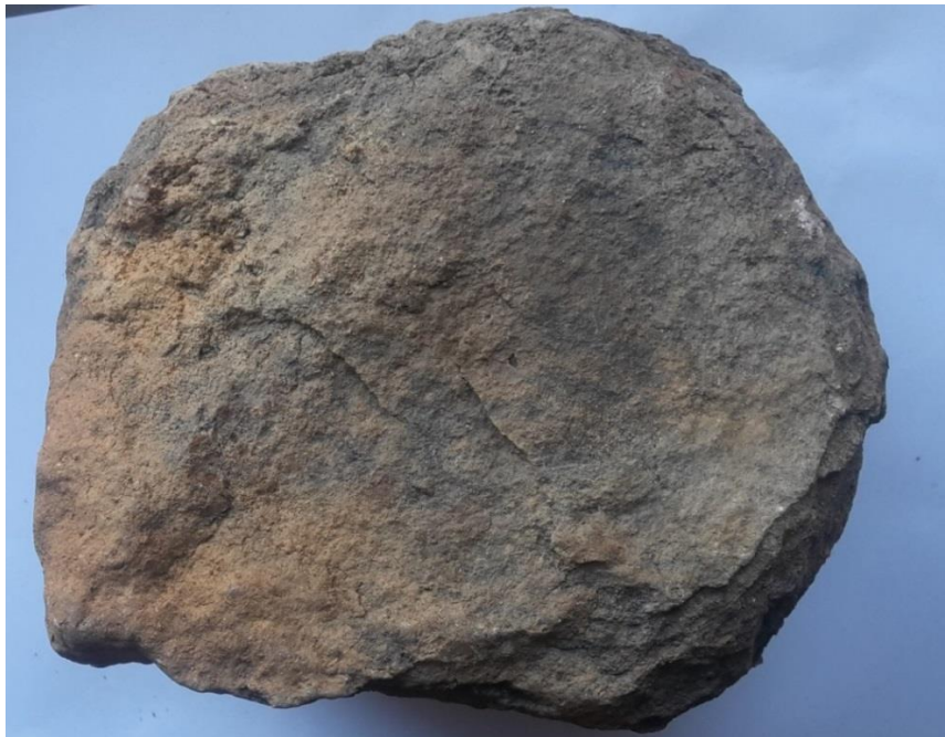
Fot. 8. Widok makroskopowy rozłupanej bryły piaskowca. Zauważalna jest złuszczająca się kora zwietrzelinowa. (Fot. M. Rembiś)
