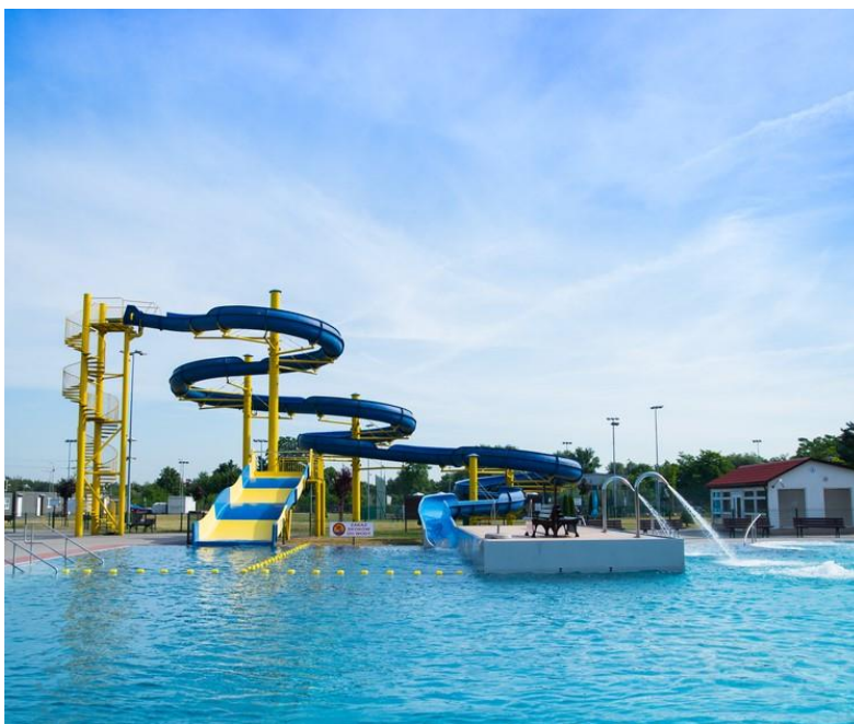
Zdjęcie: Ośrodek Rekreacyjno- Wypoczynkowy „Bugla” ul. Żeliwna 26d – niecka ze zjeżdżalnią .
