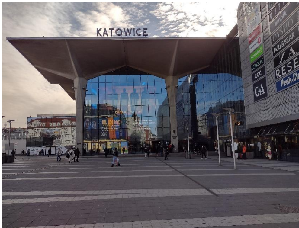
Zdjęcie: Dworzec PKP Katowice
