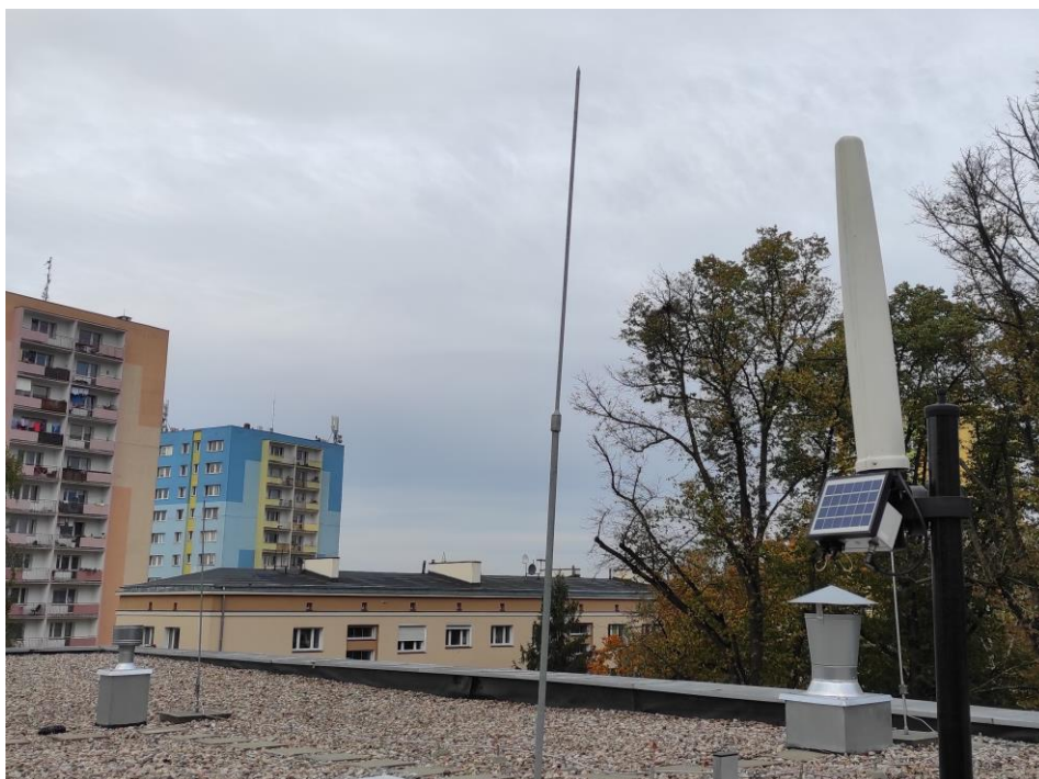
Rys. 3 Miejsce montażu SMS PEM – dach Domu Kultury „Krzemień”
