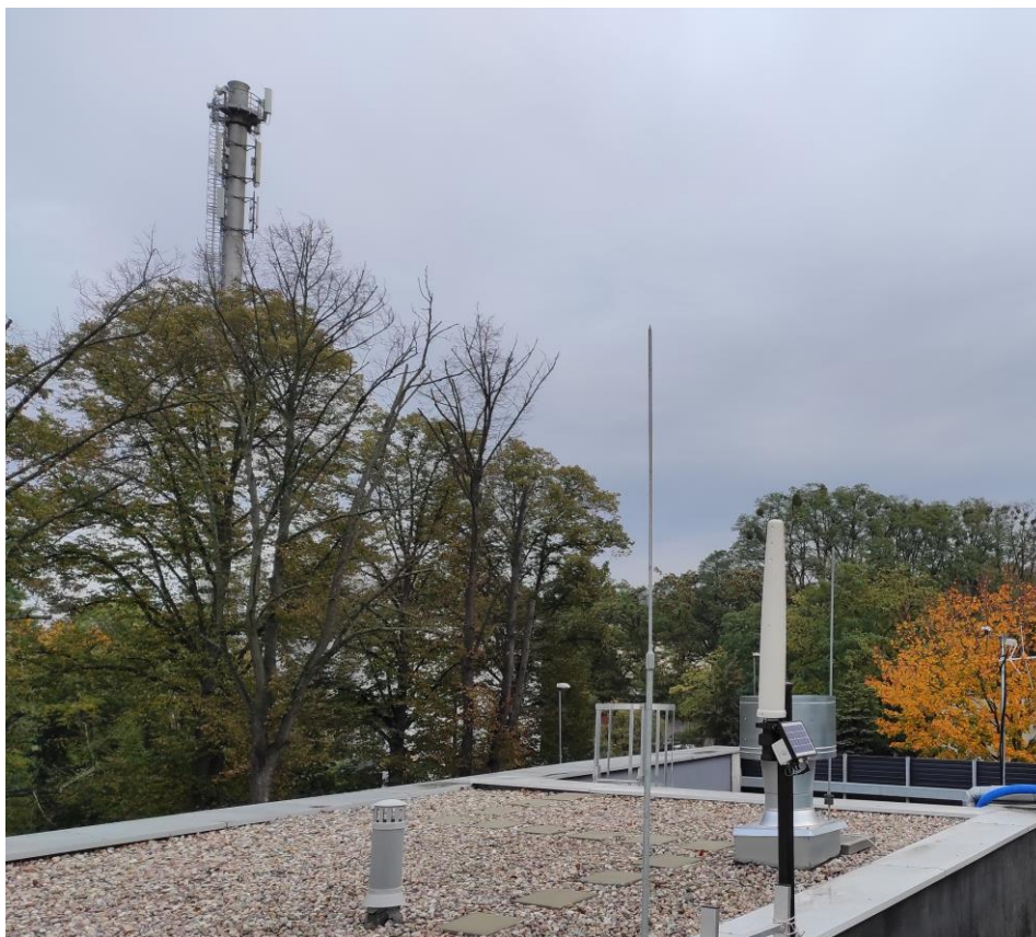
Rys. 2 Miejsce montażu SMS PEM – dach Domu Kultury „Krzemień”
