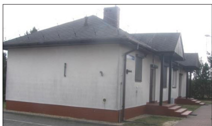
7 Budynek administracyjno - socjalny
