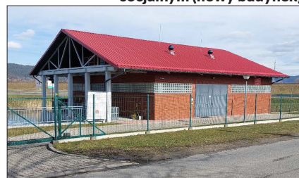
21 Budynek pompowni z zapleczem socjalnym (nowy budynek)
