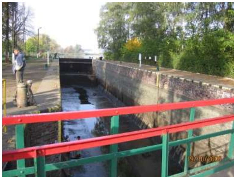
Źródło: PGW Wody Polskie Widok na odwodnioną komorę śluzy
