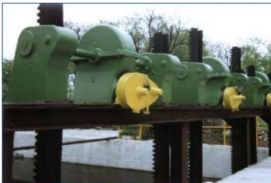
Mechanizmy wyciągowe zasuw na jazie Łława
