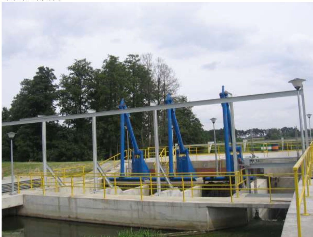
Czyszczarka krat na elektrowni wodnej Szonowo
