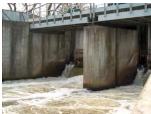
Zasuw jazu od strony wody dolnej
