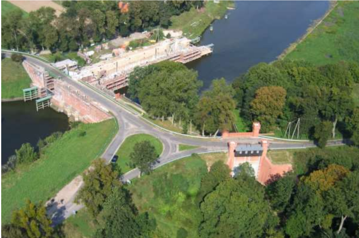
Źródło: PGW Wody Polskie Widok z lotu ptaka na węzeł Biała Góra w okresie remontu śluzy
