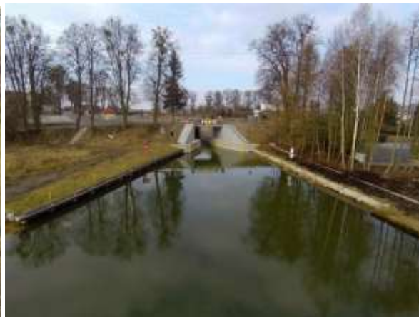
Stanowisko dolne śluzy
