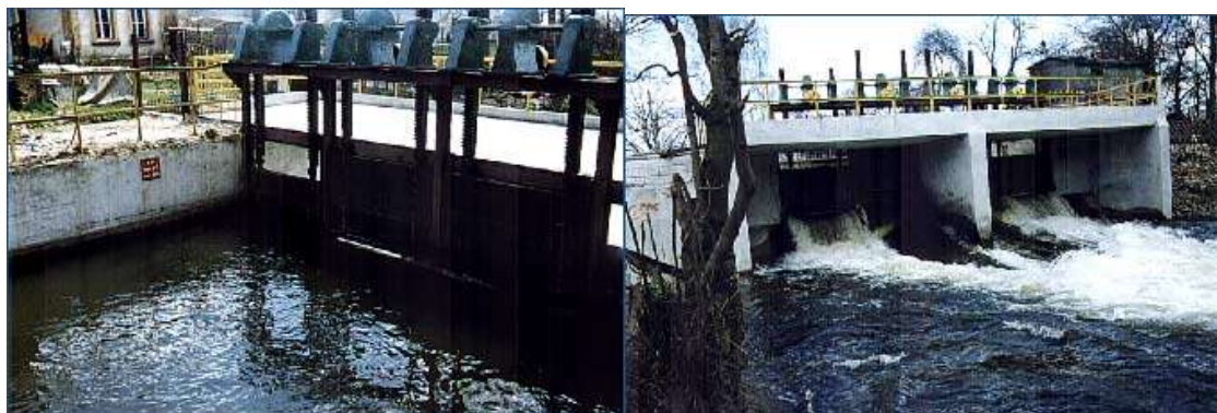
Widok od strony wody górnej
