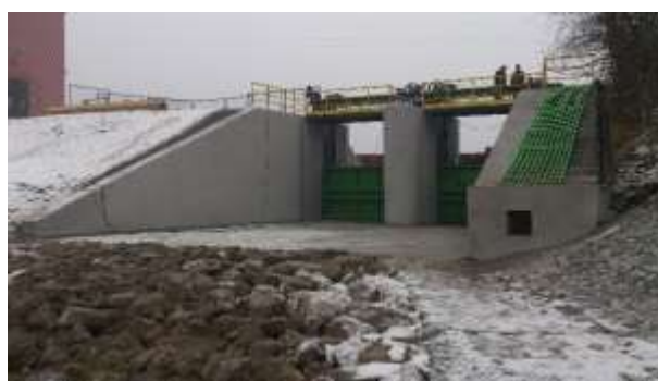
Odwodnione stanowisko dolne jazu Rakowiec
