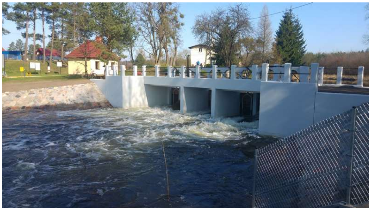
Jaz Zielona – widok od strony wody dolnej
