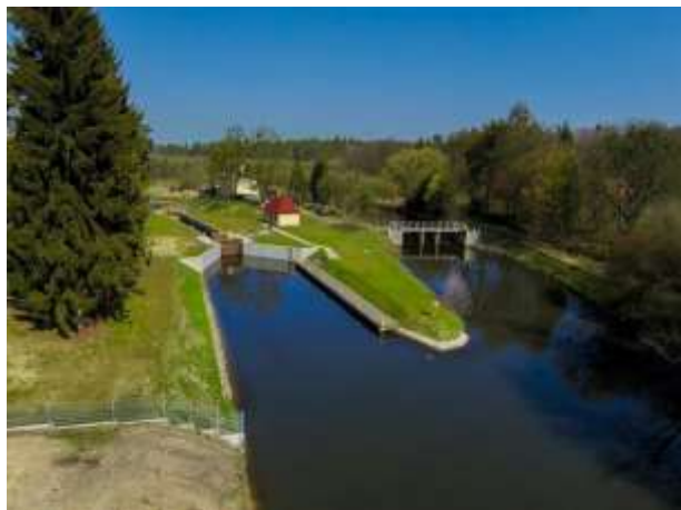
Śluza i jaz od strony wody dolnej
