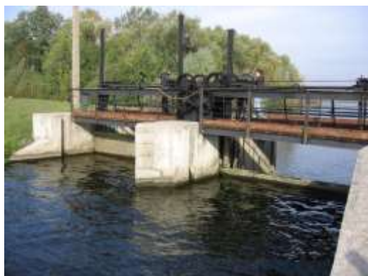
Jaz Rakowiec od strony wody górnej
