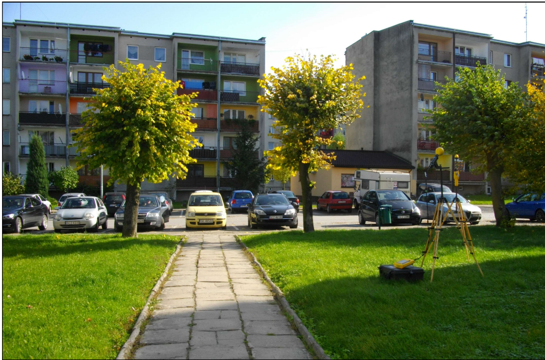
Fot.1. Rejon badań, widok w kierunku wschodnim
