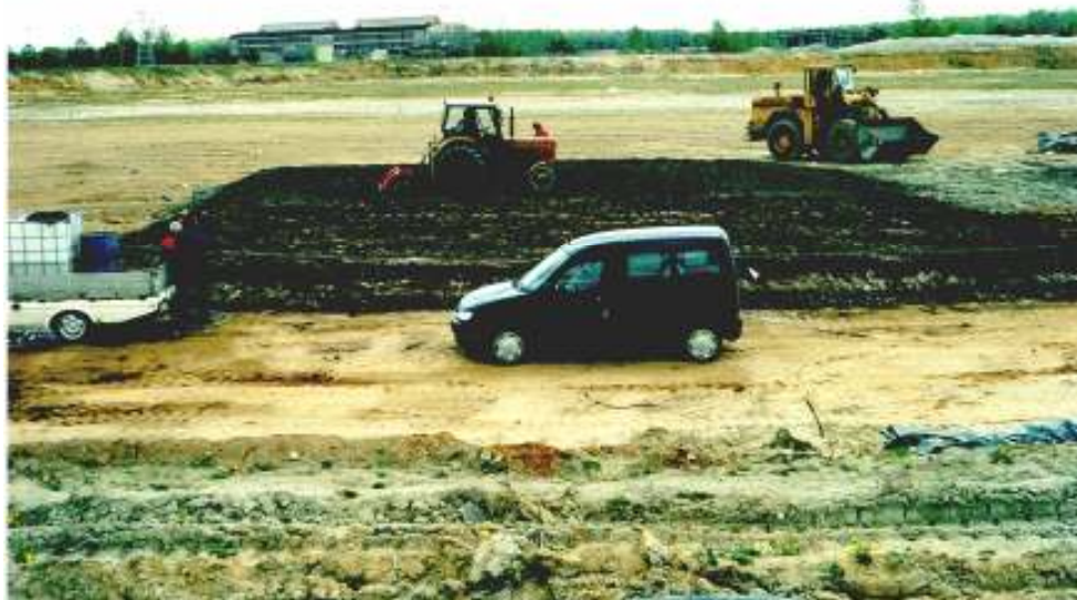
Fot. 1. Przygotowywanie gruntów do wbudowania w korpus poletka. Na poletku wykonywano badania dwóch gruntów celem wyboru jednego z nich
