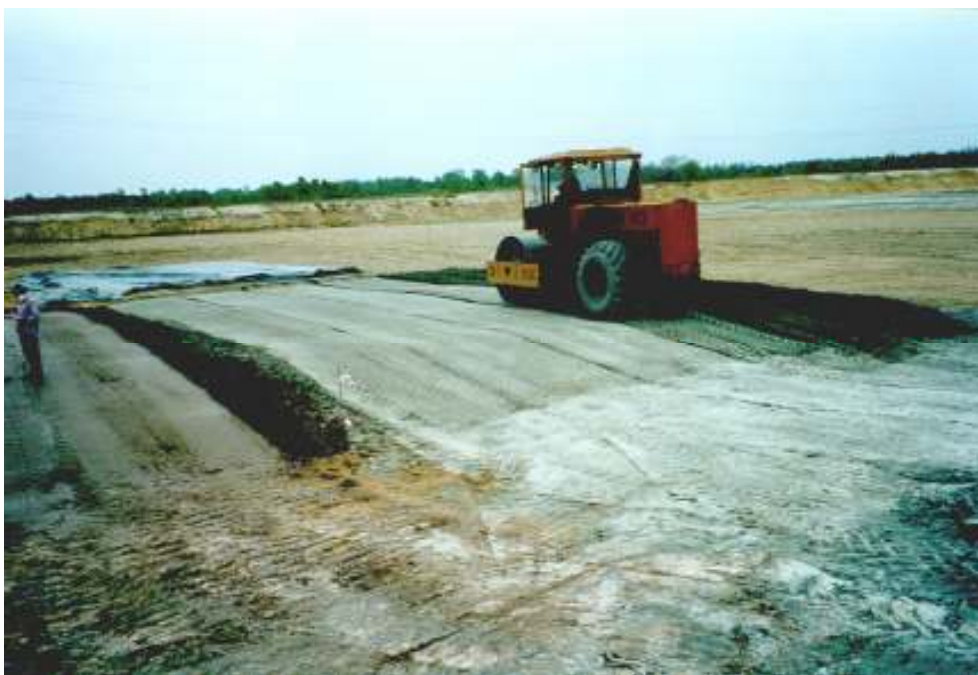
Fot. 2. Wbudowywanie kolejnych warstw uszczelnienia w korpus poletka. Warstwy o grubości 0,25 m po zagęszczeniu formowane są różnym sprzętem zagęszczającym
