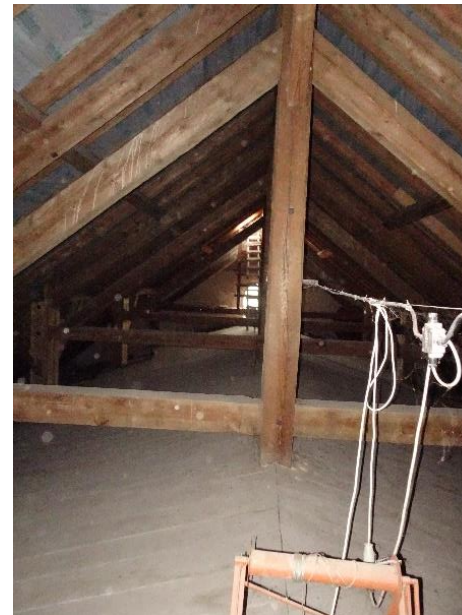
Jeden z kontrolowanych budynków
