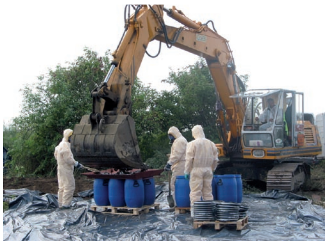
Fot. 1. Likwidacja mogilnika z odpadami pestycydowymi.
