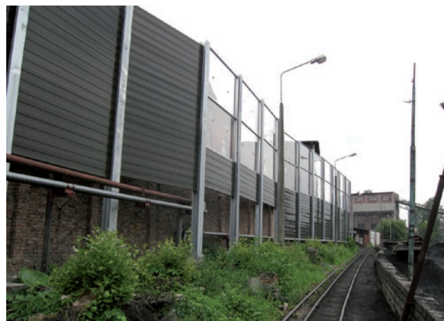
Fot. 6. Ekran akustyczny w rejonie zwalów węgla przy KWK „Wujek”
