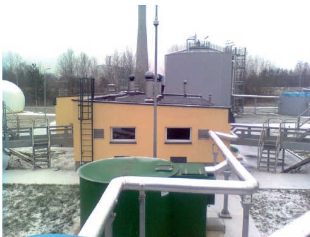
Fot. 10. Budynek techniczny obsługi fermentacji
