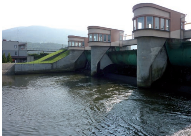
Fot. 8. Zbiornik Czaniec – zapora
