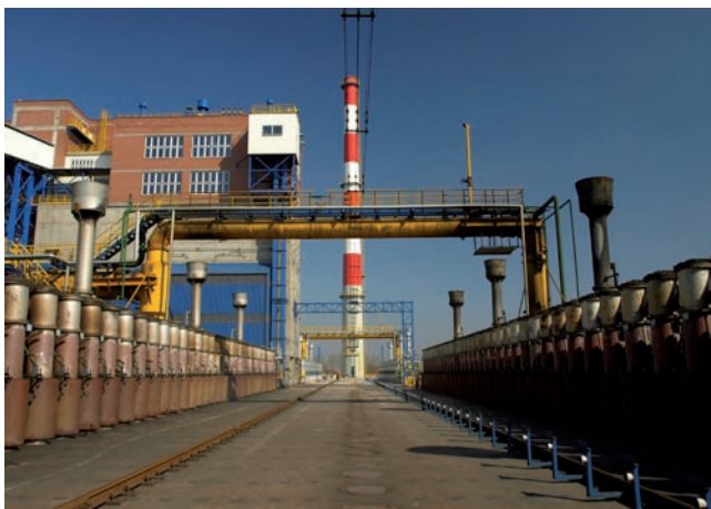
Fot. 1. Strop baterii koksowniczej w Koksowni „Radlin”
